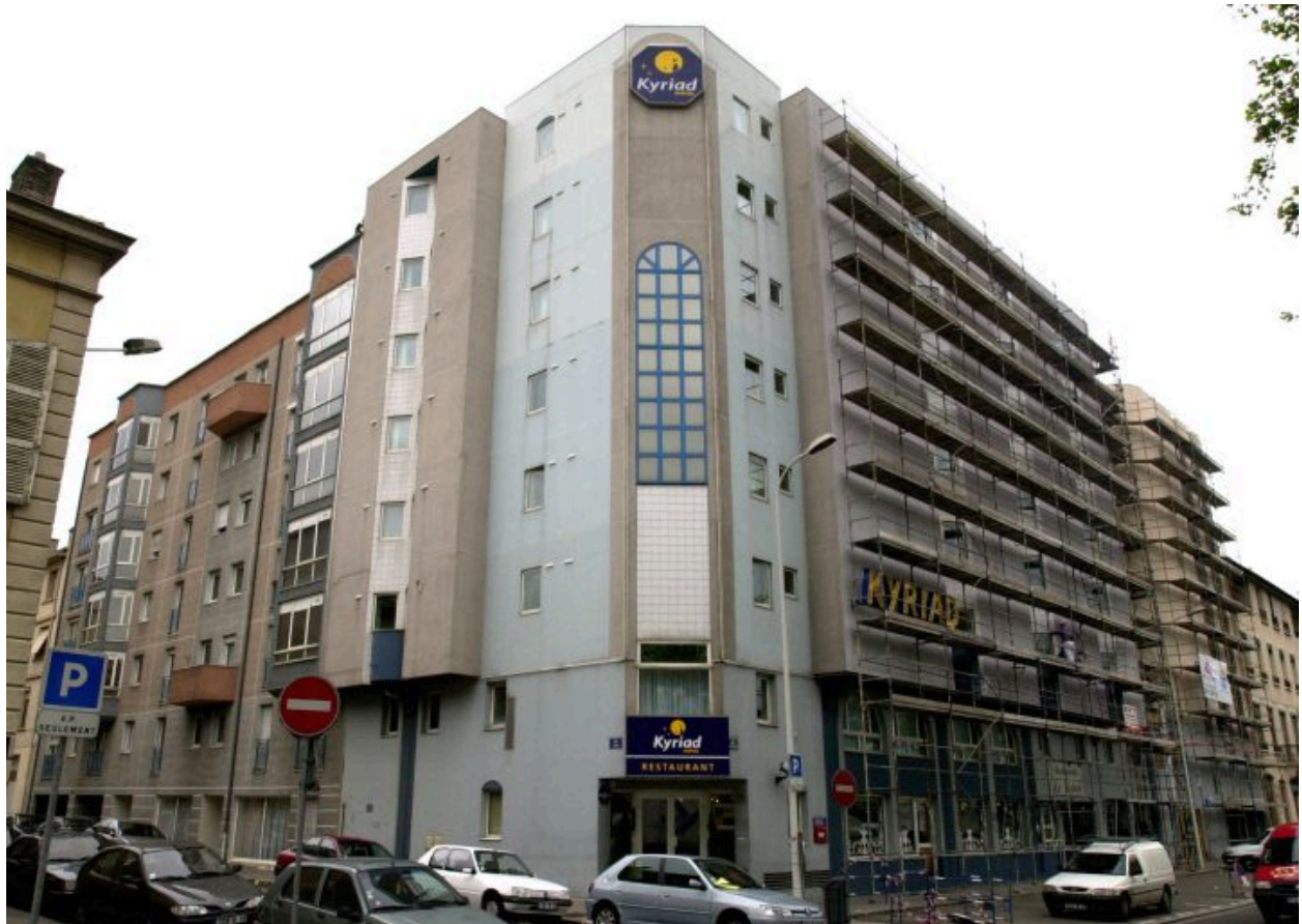
Vue d'ensemble à l'angle du quai Perrache et de la rue Ravat, depuis le sud-est
