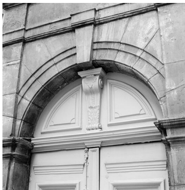
Détail du tympan de menuiserie Phot. Martial Couderette IVR82_20016900724X
