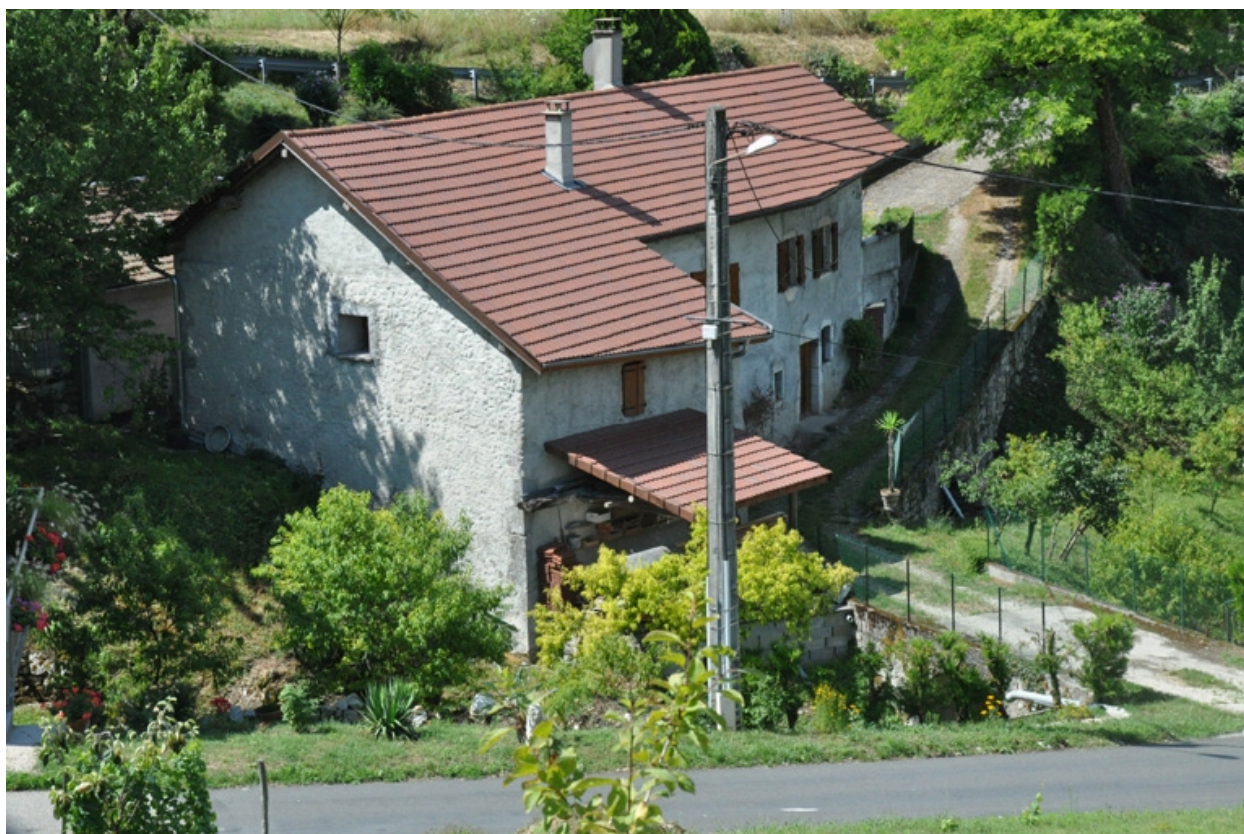
Vue générale du moulin, façades nord et est
