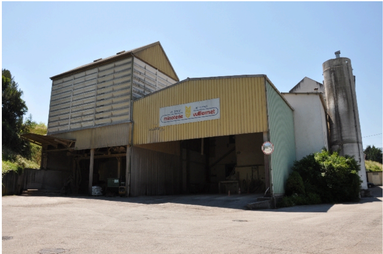
Vue générale de la minoterie Vulliermet, vue nord
