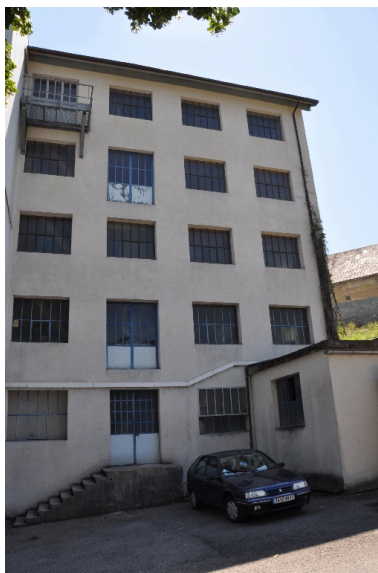
Aile ouest de la minoterie, atelier de fabrication Phot. Yannick Milleret IVR82_20127301503NUCA
