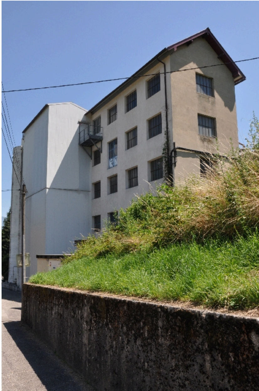
Vue sud-ouest de la minoterie
