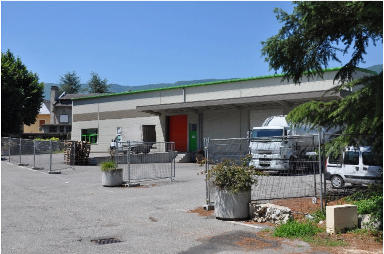
Vue est du bâtiment de stockage et d'expédition
