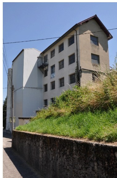
Vue sud-ouest de la minoterie Phot. Yannick Milleret IVR82_20127301504NUCA
