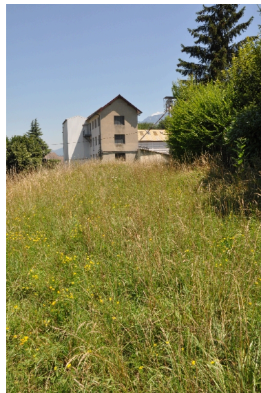
Vue de l'ancienne réserve d'eau aujourd'hui asséchée et comblée Phot. Yannick Milleret IVR82_20127301507NUCA
