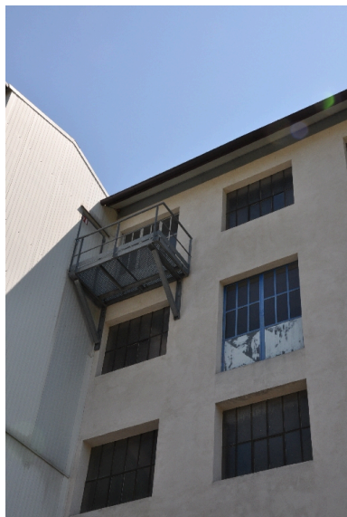
Détail de la façade ouest avec une passerelle extérieure Phot. Yannick Milleret IVR82_20127301506NUCA
