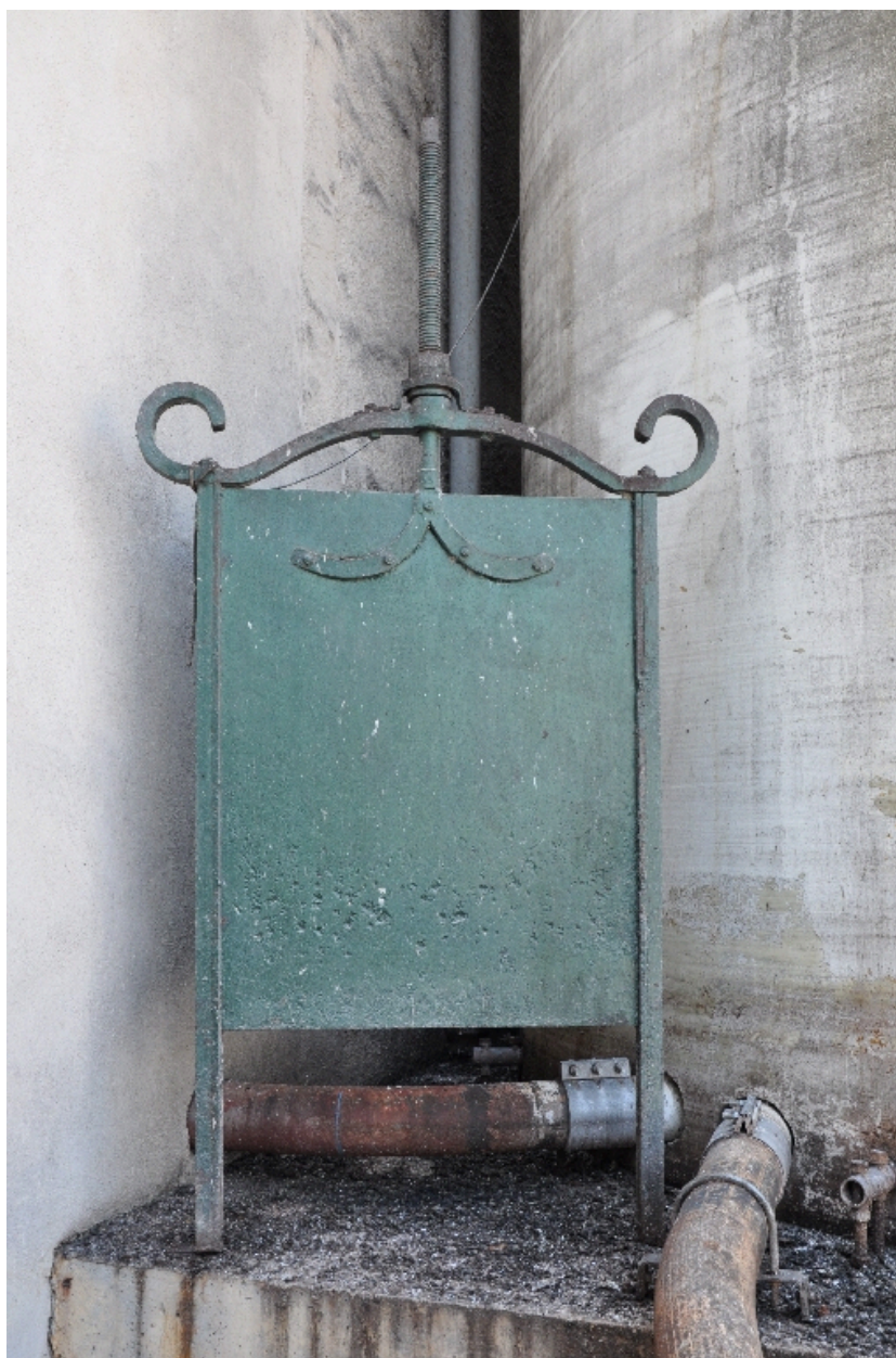
Ancienne écluse du canal d'amenée des moulins Vulliermet
