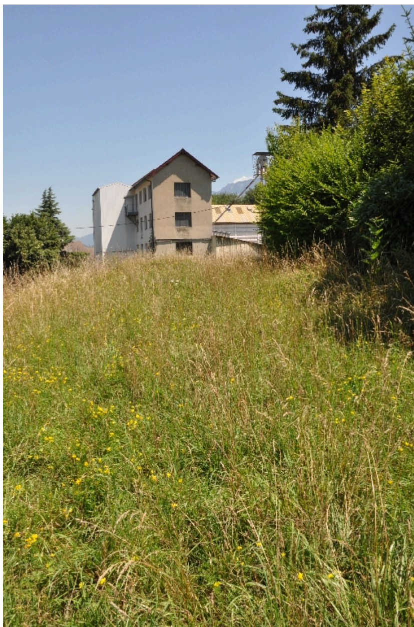
Vue de l'ancienne réserve d'eau aujourd'hui asséchée et comblée
