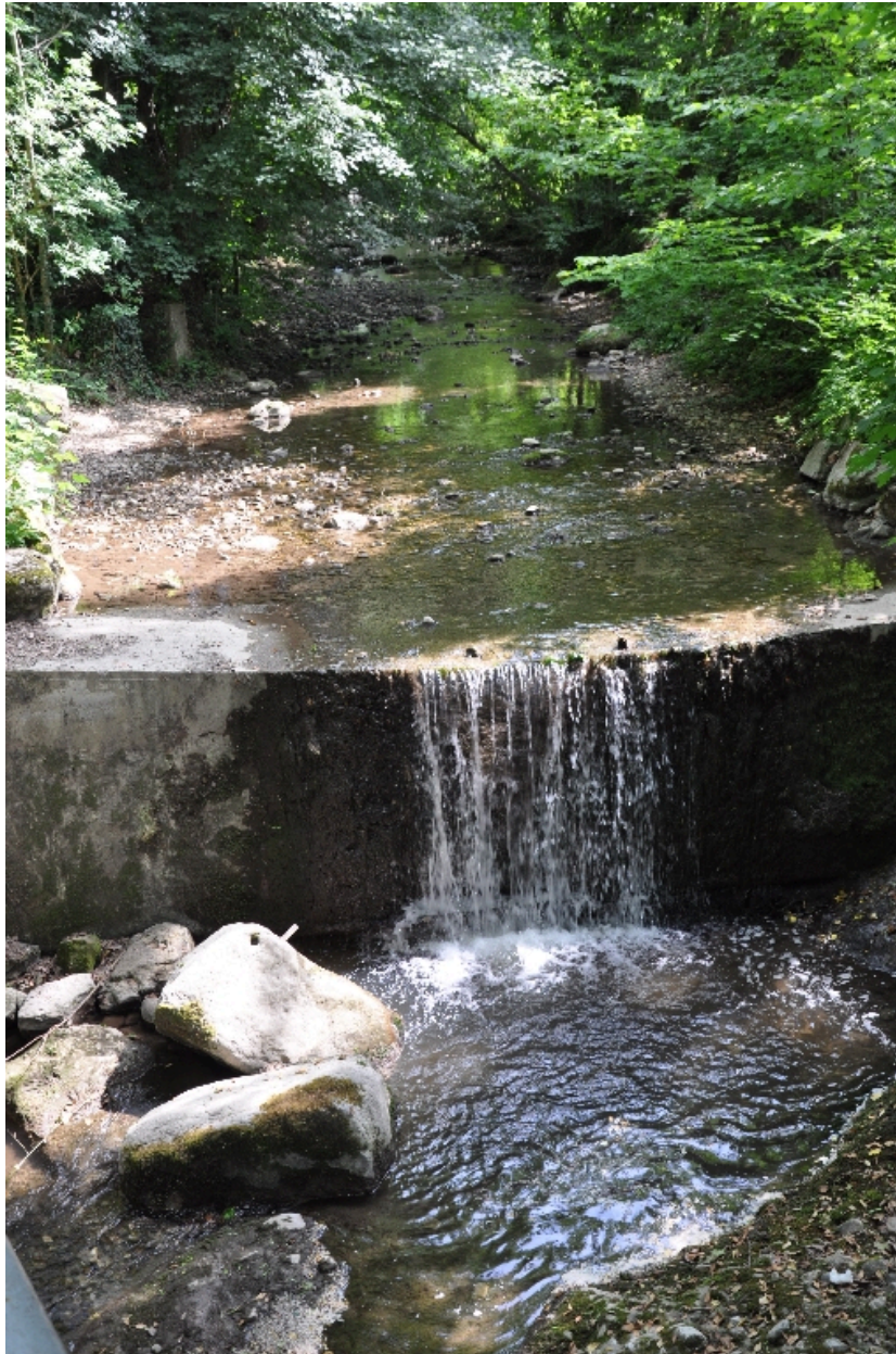
Vue de l'ancien seuil de la prise d'eau des moulins Vulliermet sur le Nant Bruyant
