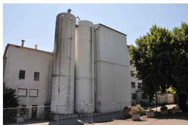
Vue ouest, partie administrative et silos de stockage Phot. Yannick Milleret IVR82_20127301502NUCA
