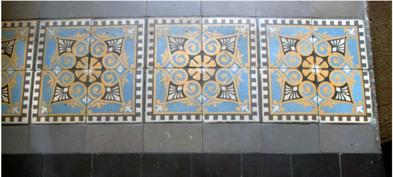
La frise de carrelage séparant le vestibule de la cage d'escalier
