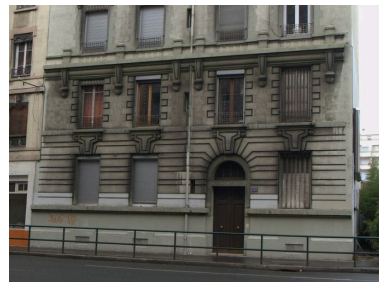
Détail du rez-de-chaussée Phot. Maryannick Chalabi IVR82_20086900800NUCA
