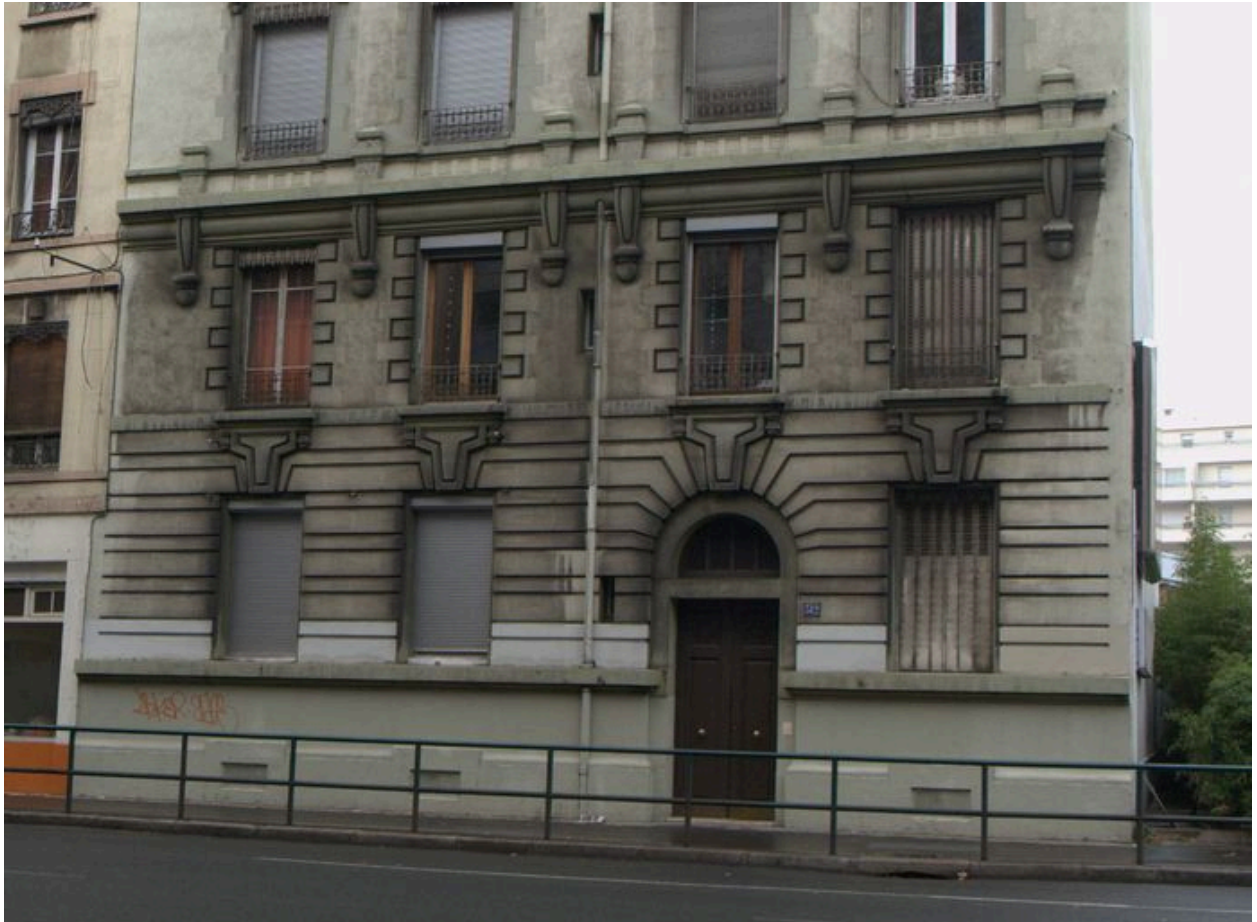
Détail du rez-de-chaussée
