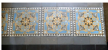
La frise de carrelage séparant le vestibule de la cage d'escalier Phot. Maryannick Chalabi IVR82_20086900808NUCA
