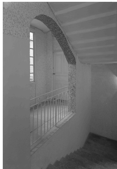
Cage d'escalier. Phot. Jean-Marie Refflé IVR82_19900100281P
