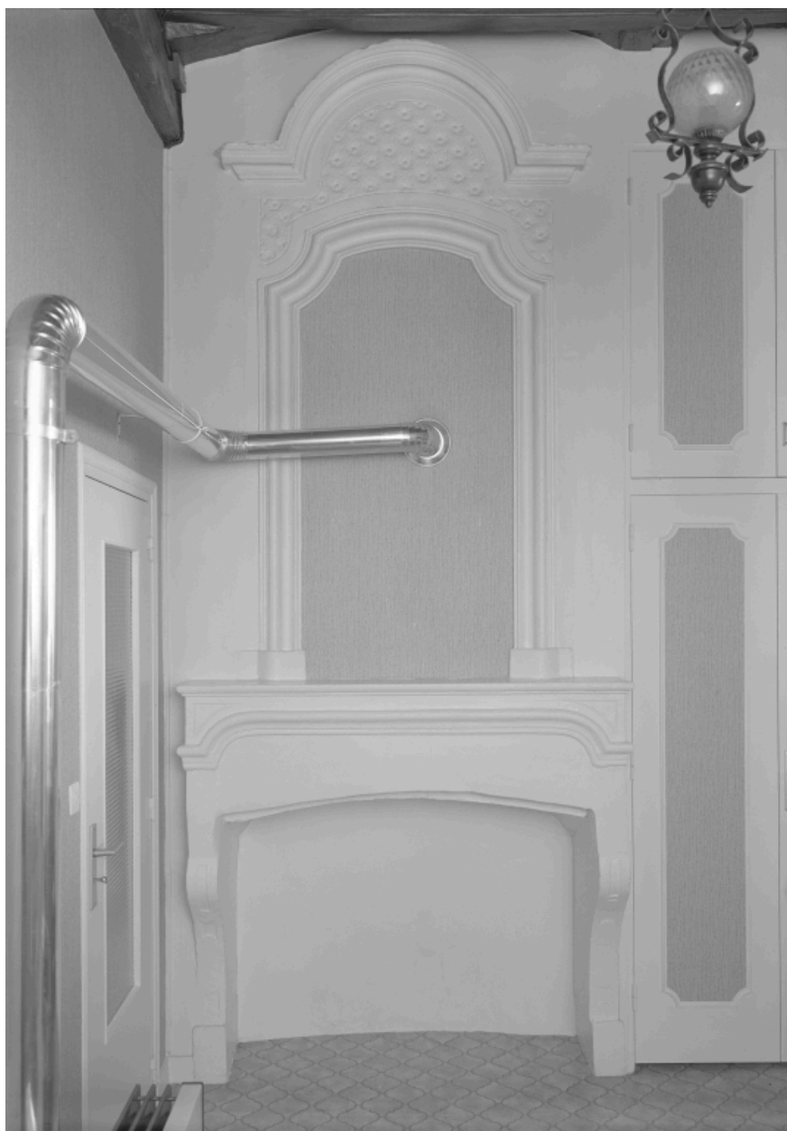
Cheminée engagée (autrefois adossée), 2e étage.
