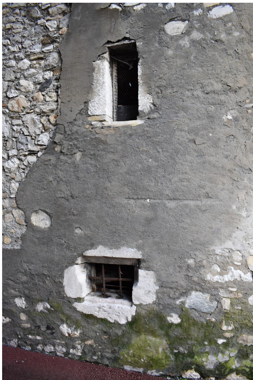
Elévation nord, angle ouest, détail des ouvertures.
