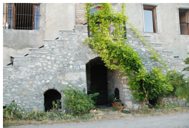
Détail de l'escalier extérieur. Phot. Caroline Guibaud IVR84_20247301471NUCA
