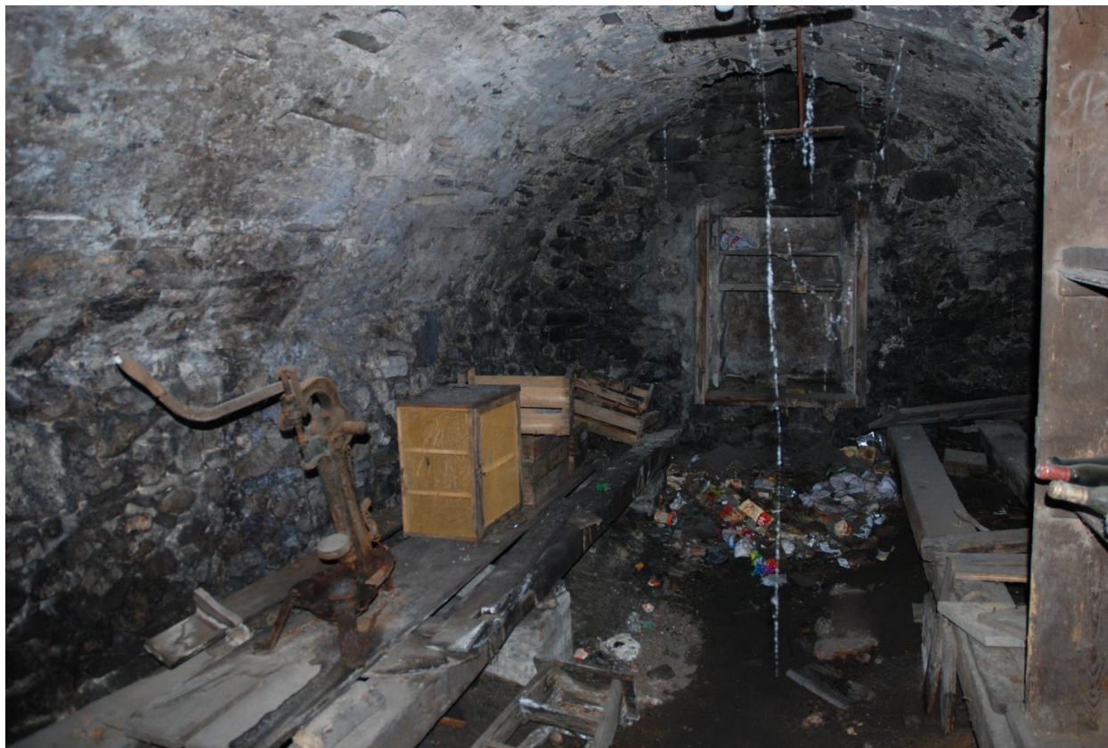
Vue intérieure du sous-sol : cave médiane, vue vers le nord.
