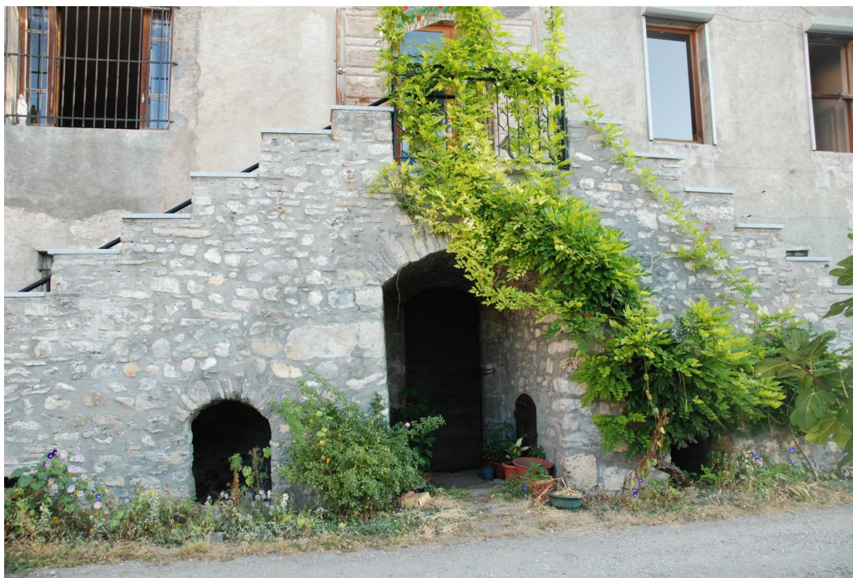
Détail de l'escalier extérieur.
