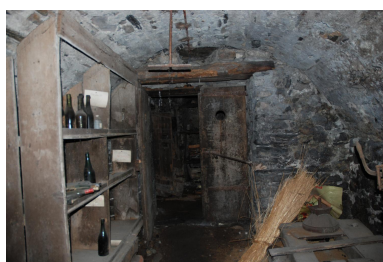
Vue intérieure du sous-sol : cave médiane, vue vers la porte. Phot. Caroline Guibaud IVR84_20247301557NUCA
