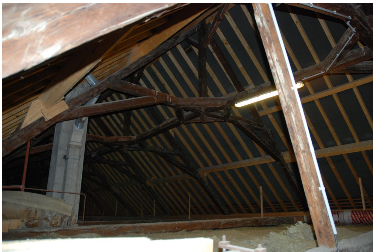
Vue intérieure de la charpente.
