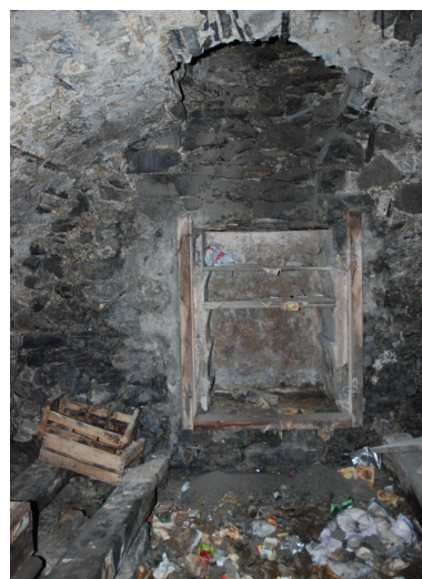
Vue intérieure du sous-sol : cave médiane, vue vers le nord. Phot. Caroline Guibaud IVR84_20247301556NUCA
