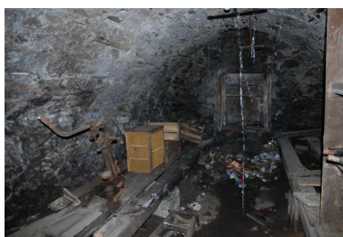
Vue intérieure du sous-sol : cave médiane, vue vers le nord. Phot. Caroline Guibaud IVR84_20247301555NUCA
