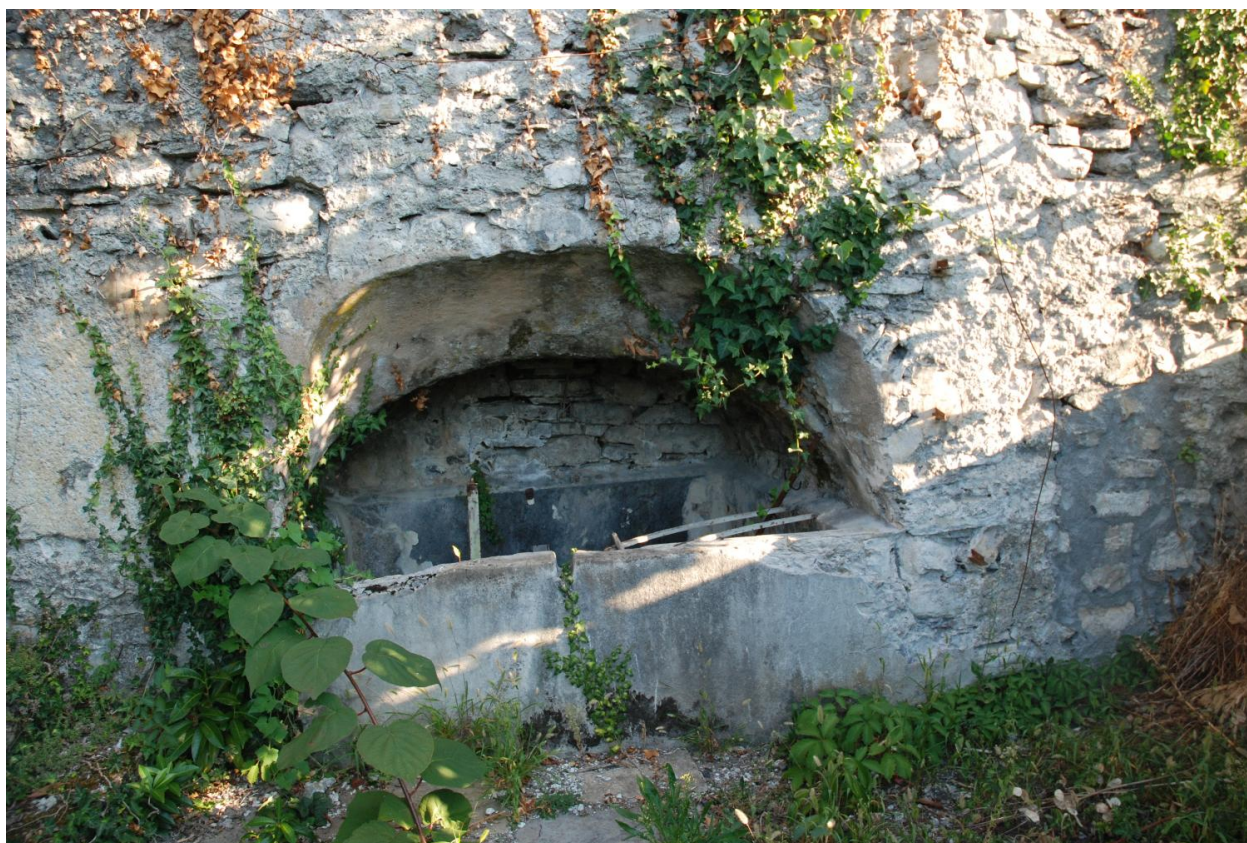
Détail de la fontaine.
