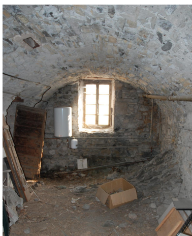
Vue intérieure de l'étage de soubassement, 3e travée de cave ; à droite, l'extrados de la voûte couvrant l'escalier d'accès au sous-sol. Phot. Caroline Guibaud IVR84_20247301558NUCA
