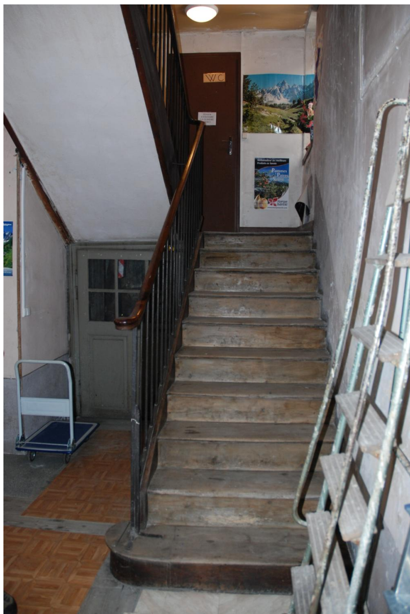
Vue intérieure du rez-de-chaussée surélevé : escalier.
