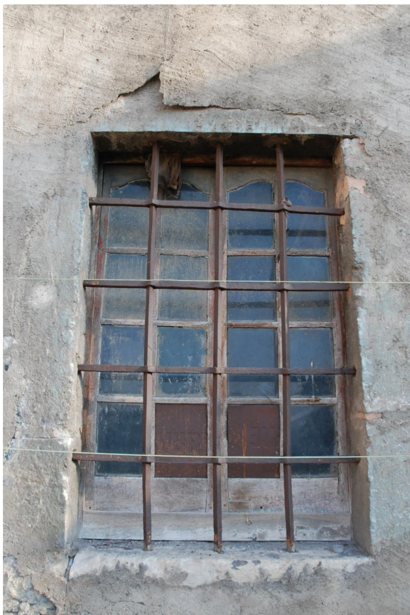
Etage de soubassement, détail de la fenêtre sud de la 2e travée de cave.
