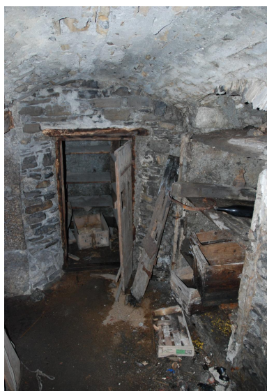
Vue intérieure du sous-sol : espace voûté et placard à l'arrivée de l'escalier. Phot. Caroline Guibaud IVR84_20247301554NUCA
