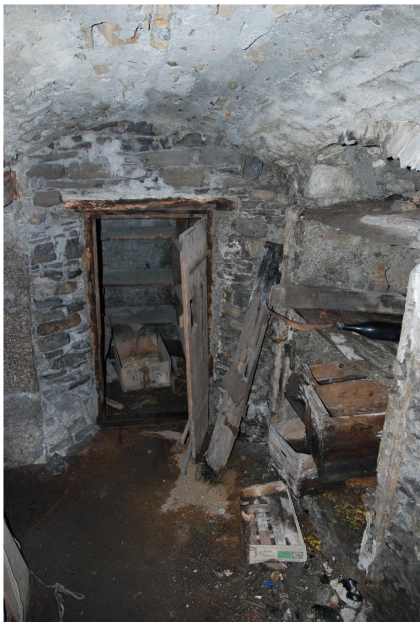
Vue intérieure du sous-sol : espace voûté et placard à l'arrivée de l'escalier.
