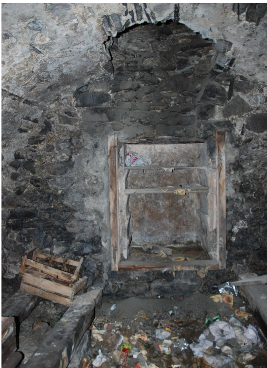
Vue intérieure du sous-sol : cave médiane, vue vers le nord.
