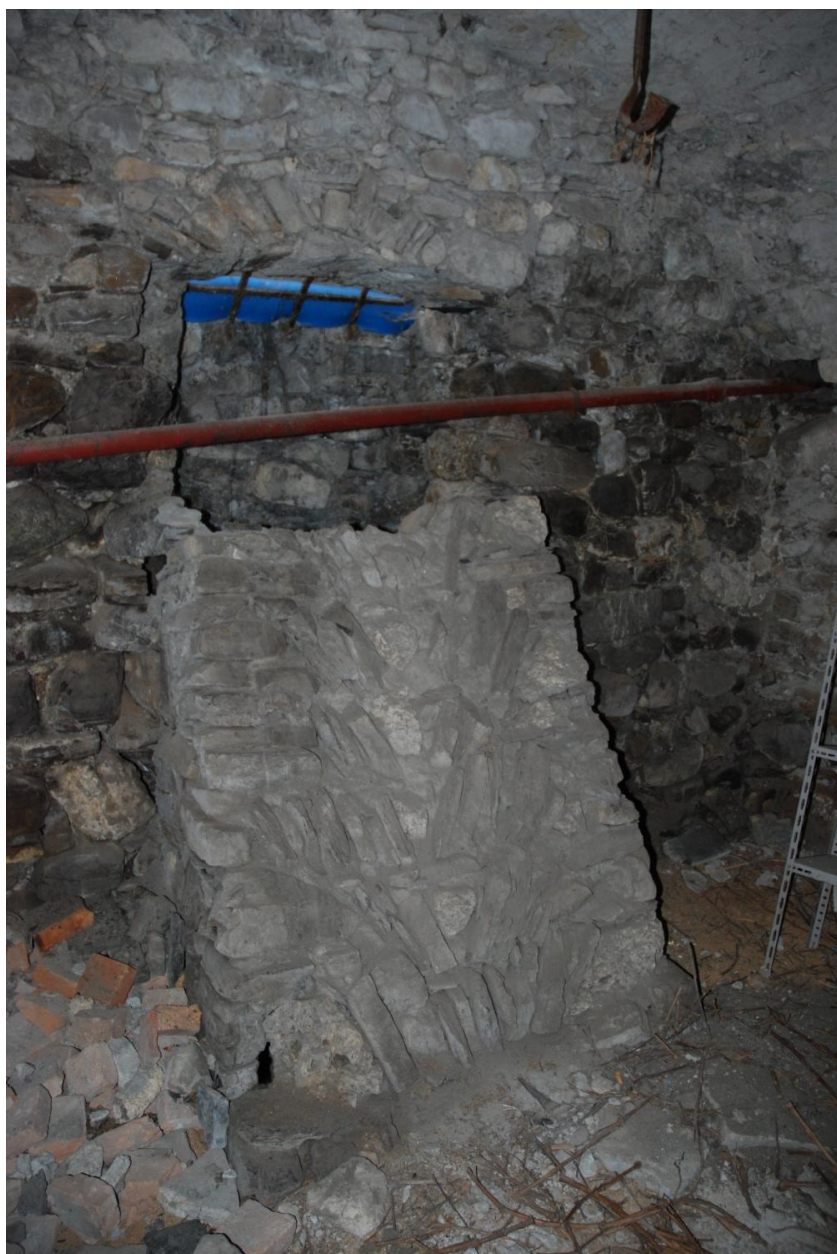
Vue intérieure de l'étage de soubassement, 3e travée de cave : détail du conduit du jour de la cave en sous-sol.
