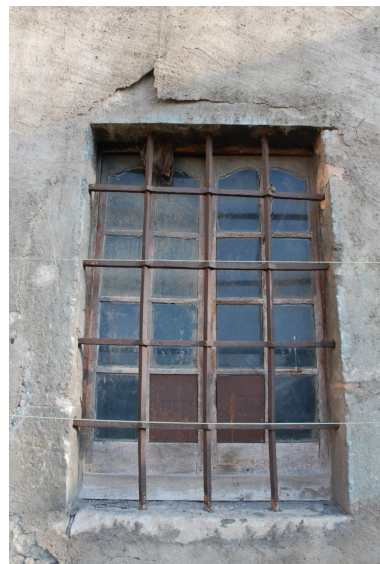
Etage de soubassement, détail de la fenêtre sud de la 2e travée de cave. Phot. Caroline Guibaud IVR84_20247301480NUCA
