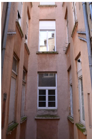
Façade ouest Phot. Noémie Caillat IVR82_20156900274NUCA
