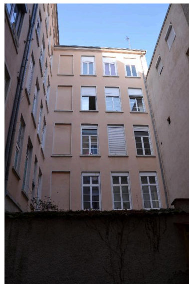
Façade est Phot. Noémie Caillat IVR82_20156900292NUCA
