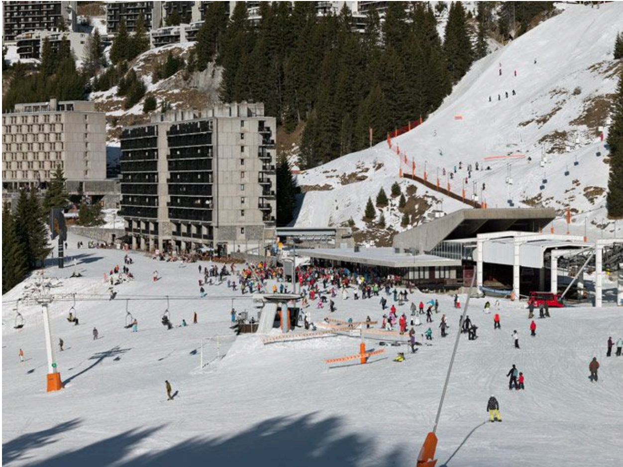
Vue depuis le sud
