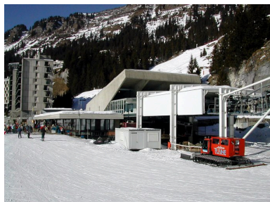
Vue depuis le sud-est. Le départ des cabines Phot. ENSAG APM IVR82_20127401182NUCA
