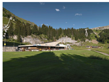
Vue d'ensemble depuis le sud-ouest Phot. Eric Dessert IVR82_20097400337NUCA
