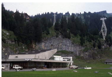
Vue depuis le nord-est Phot. ENSAG APM IVR82_20127401179NUCA
