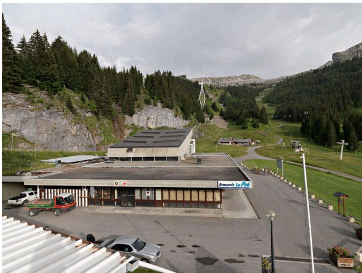
Vue depuis l'ouest
