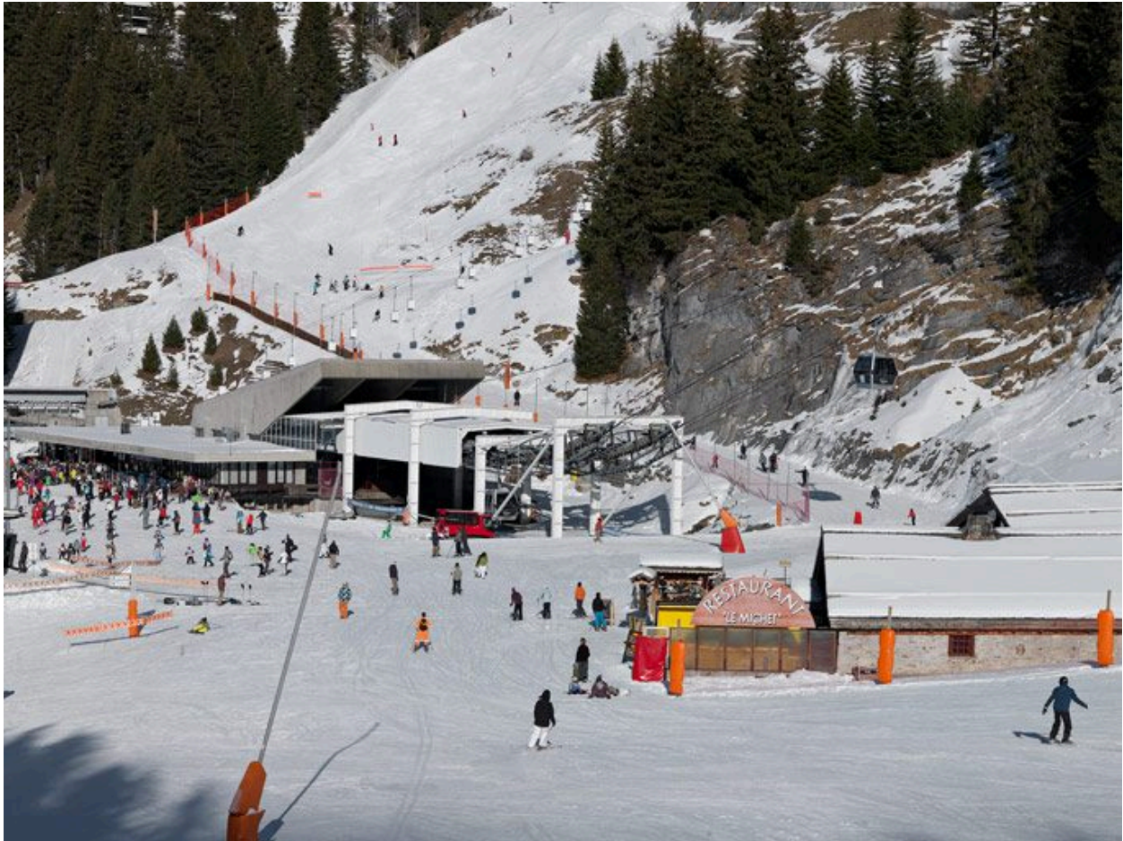
Vue depuis le sud-est
