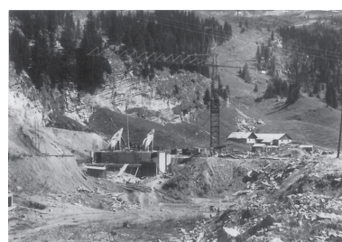
Construction des fondations de la gare, 1963 (A. privées Berlottier) Phot. Jean-François Lyon-Caen IVR82_20127401572NUC
