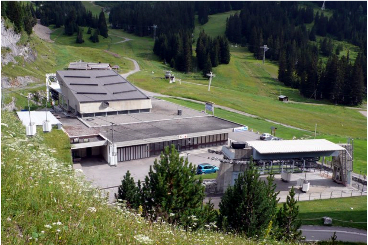
La gare inférieure du télébenne des Grands Vans. A l'arrière celle du téléférique des Grandes Platières
