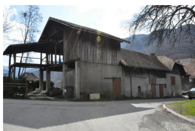
Vue du bâtiment. Phot. Clara Bérelle IVR84_20167301780NUCA
