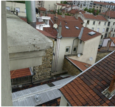
Vue des toitures Phot. Nadine Halitim-Dubois IVR82_20096903830NUCA
