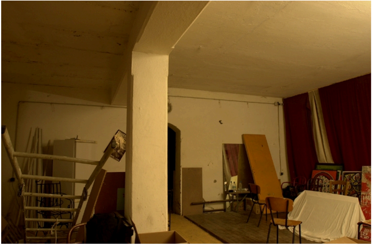
Vue des sous-sol
