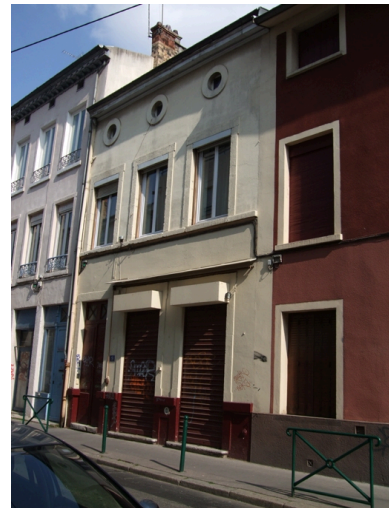
Façade rue Creuzet Phot. Nadine Halitim-Dubois IVR82_20096903825NUCA
