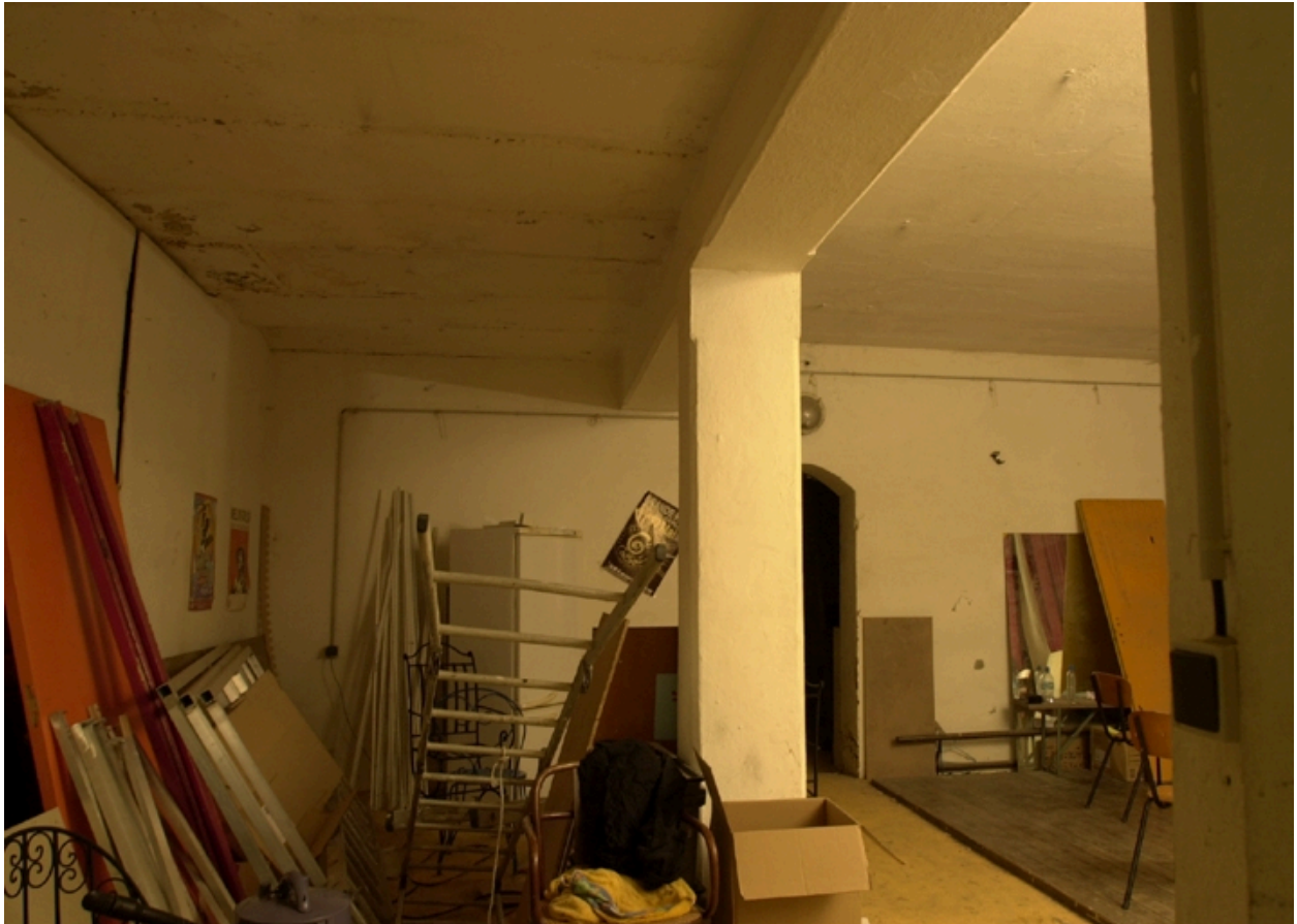
Vue des sous-sol, détail pilier béton
