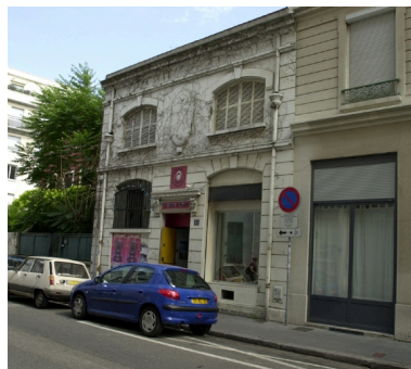
Vue d'ensemble est Phot. Nadine Halitim-Dubois IVR82_20096903828NUCA
