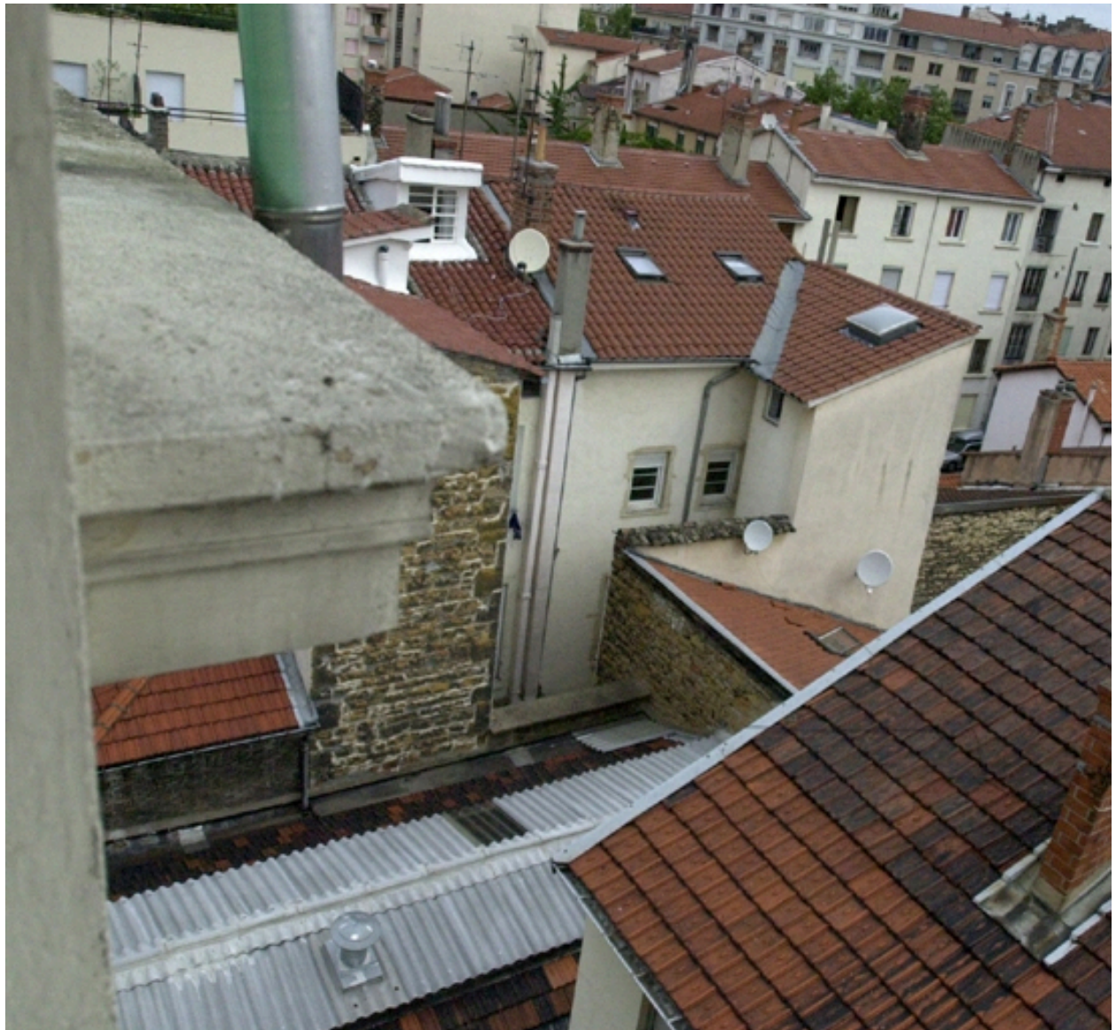
Vue des toitures
