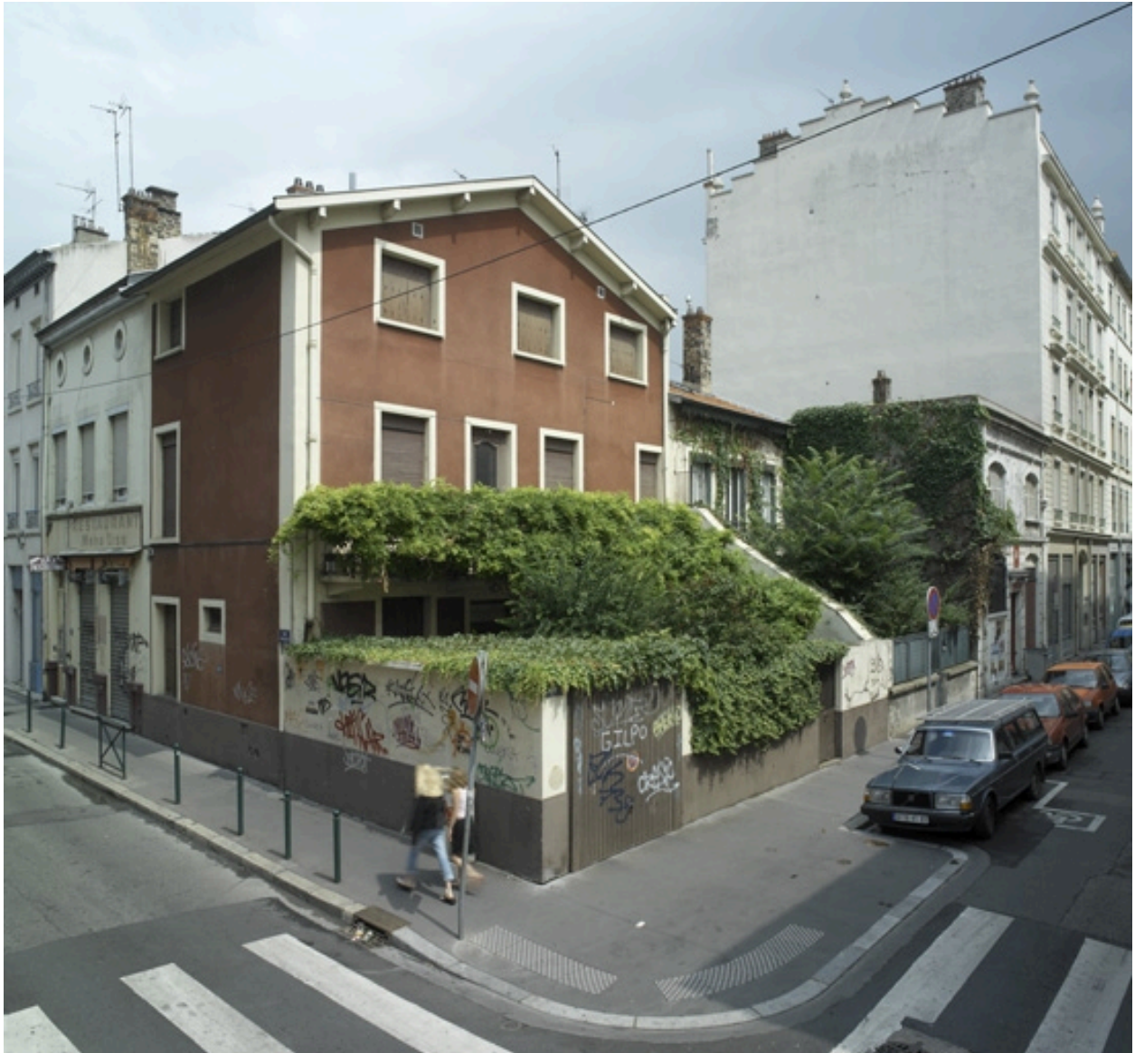
Vue générale sud-ouest, angle de rue
