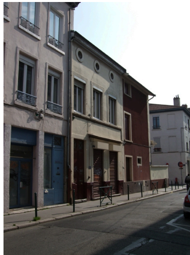
Façade 9 rue Creuzet Phot. Nadine Halitim-Dubois IVR82_20096903824NUCA
