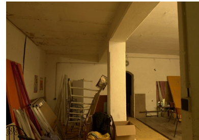
Vue des sous-sol, détail pilier béton Phot. Nadine Halitim-Dubois IVR82_20096903835NUCA
