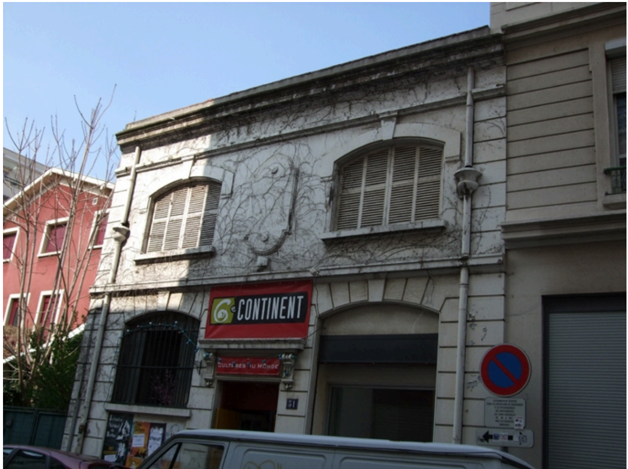
Façade principale, vue sud
