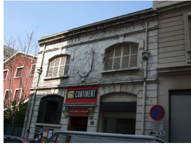
Façade principale, vue sud Phot. Nadine Halitim-Dubois IVR82_20096903822NUCA
