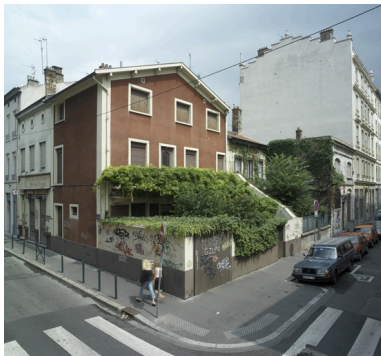
Vue générale sud-ouest, angle de rue Phot. Didier Gourbin IVR82_20056900053NUCA
