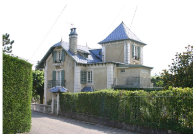
Façades orientales Phot. François Fouger IVR82_20067300646NUCA
