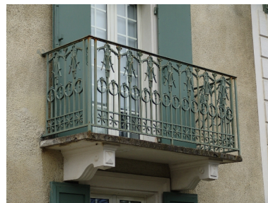
Détail d'un balcon Phot. François Fouger IVR82_20077300291NUCA
