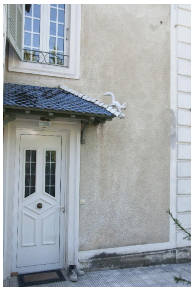
Détail de l'entrée Phot. Denys Harreau IVR82_20137300969NUCA
