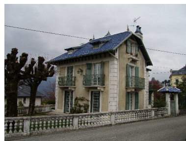
Vue générale du sud-est Phot. François Fouger IVR82_20097300053NUCA
