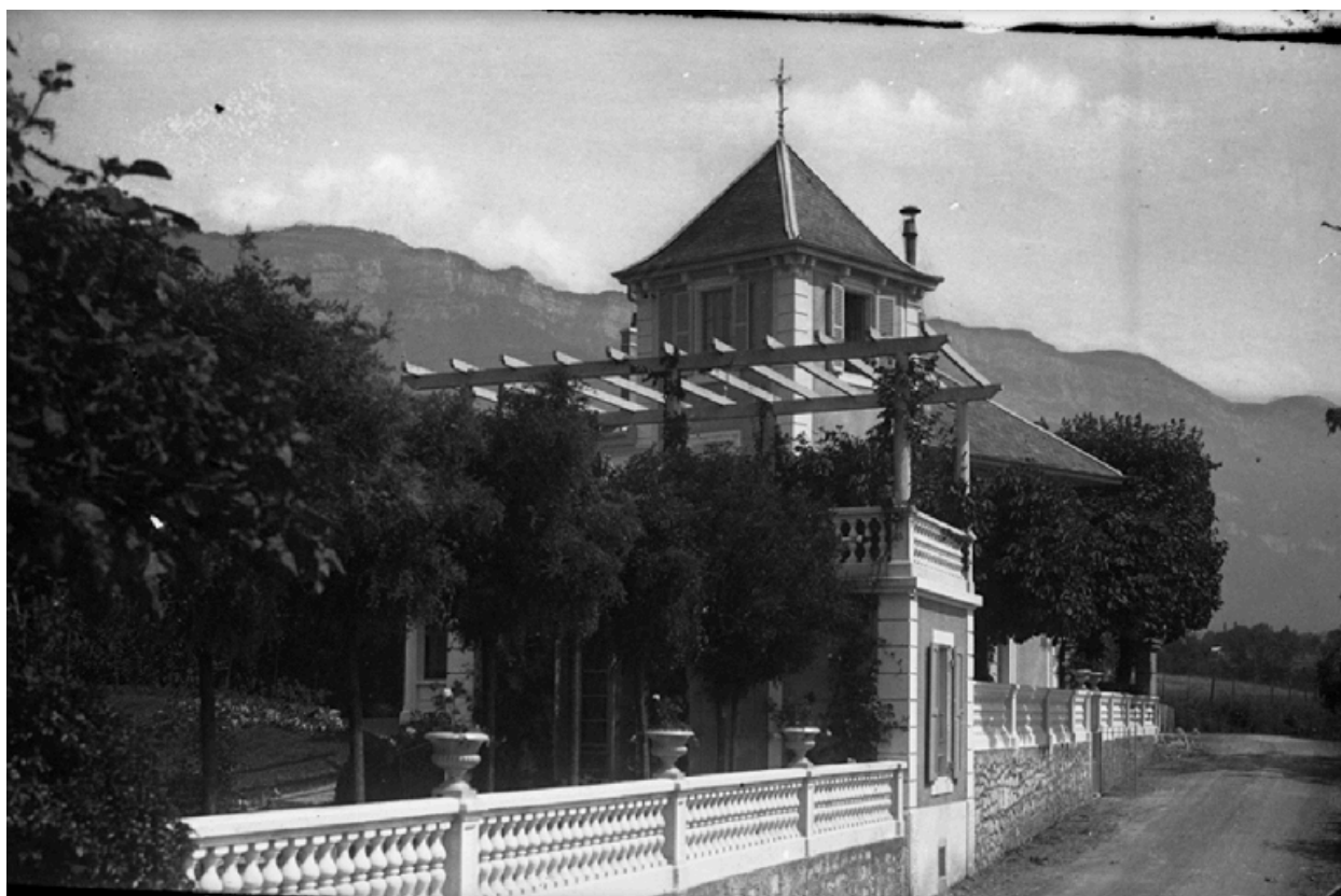
Vue prise du nord-ouest
