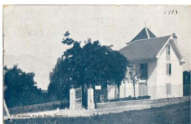
Vue prise du sud-est, vers 1910-1915 Repro. Philippe Gras IVR84_20177300459NUCB
