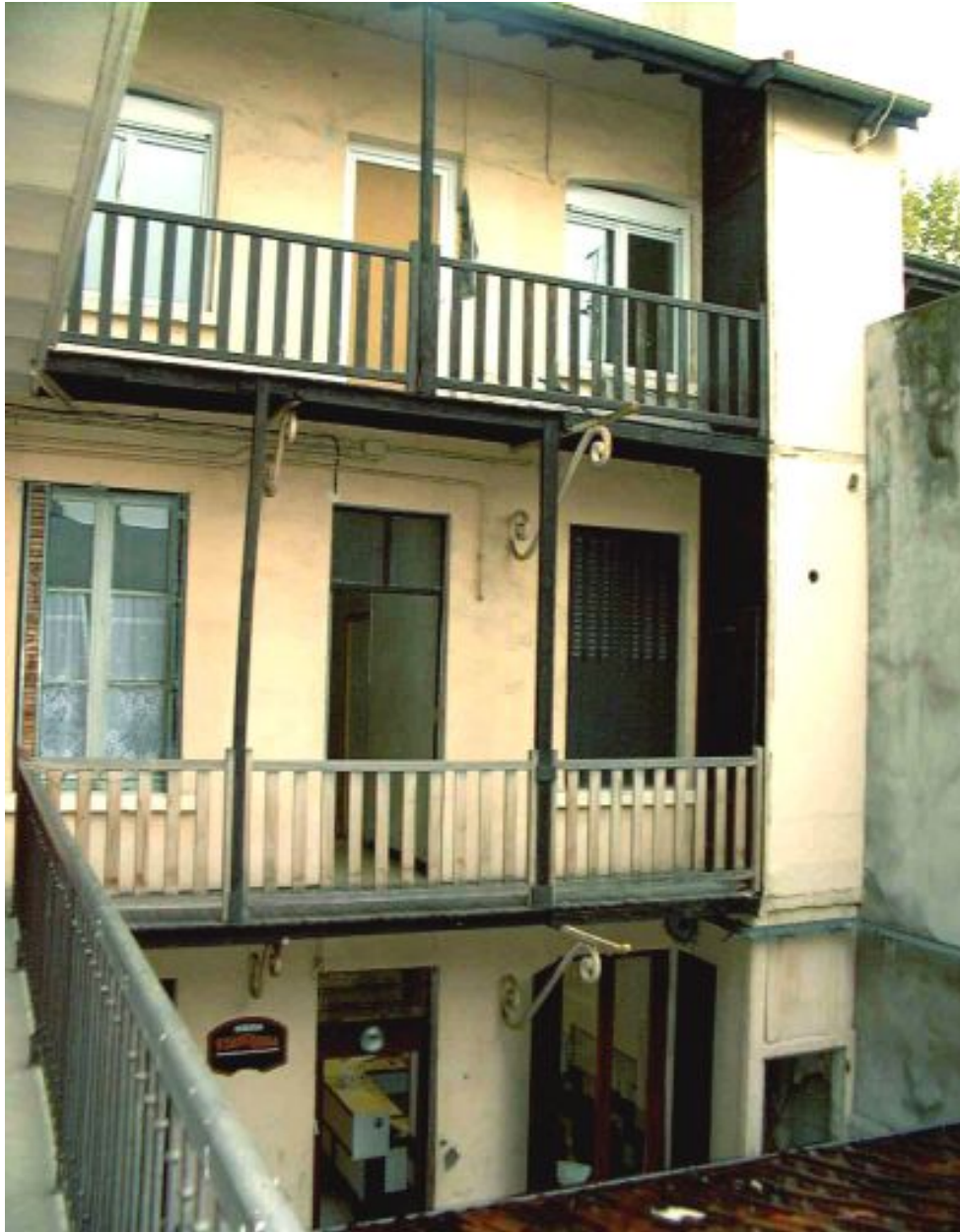
Détail des coursières sur la cour
