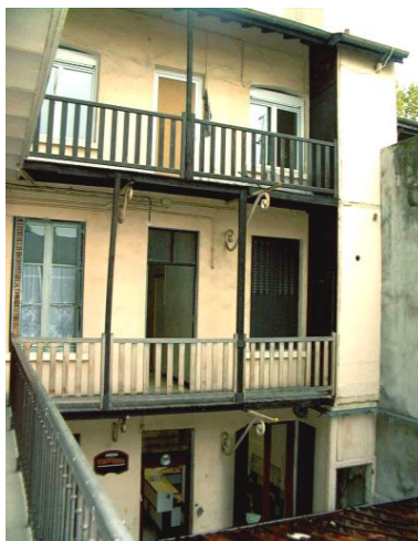
Détail des coursières sur la cour Phot. Bernard Ducouret IVR82_20006900553NUCA
