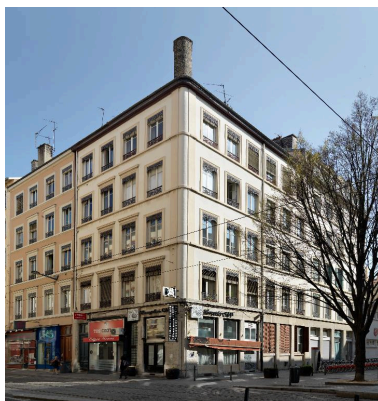
Vue d'ensemble Phot. Eric Dessert IVR84_20176900453NUCAQ
