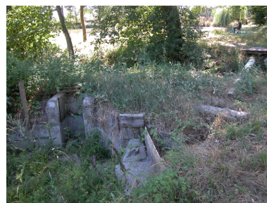
Vue d'une serve. Phot. Thierry Monnet IVR82_20134201839NUCA
