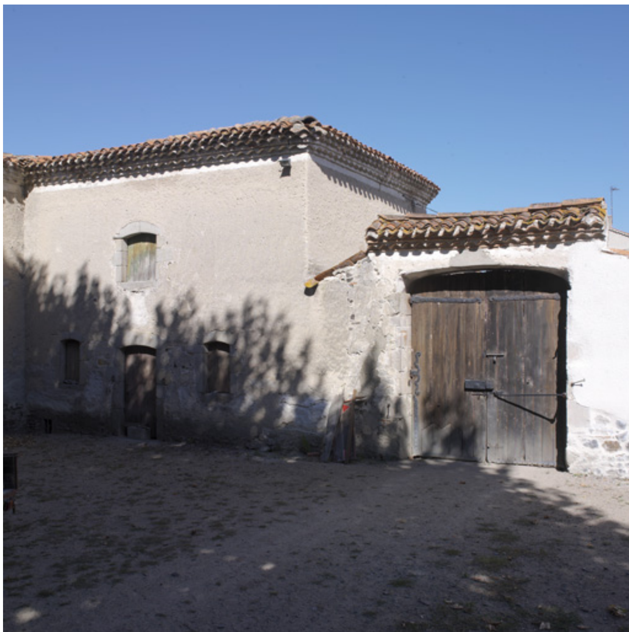
Vue du portail de la cour de la demeure et du pavillon sud, depuis l'est.
