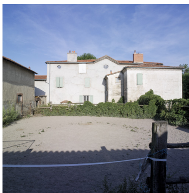
Vue arrière (ouest) de la demeure. Phot. Didier Gourbin IVR82_20054202075NUCA
