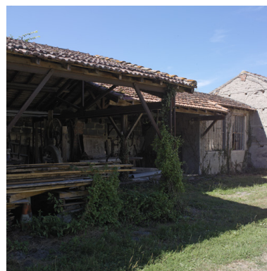
IVR82_20054202054NUCA Vue de l'atelier. Phot. Didier Gourbin IVR82_20054202057NUCA
