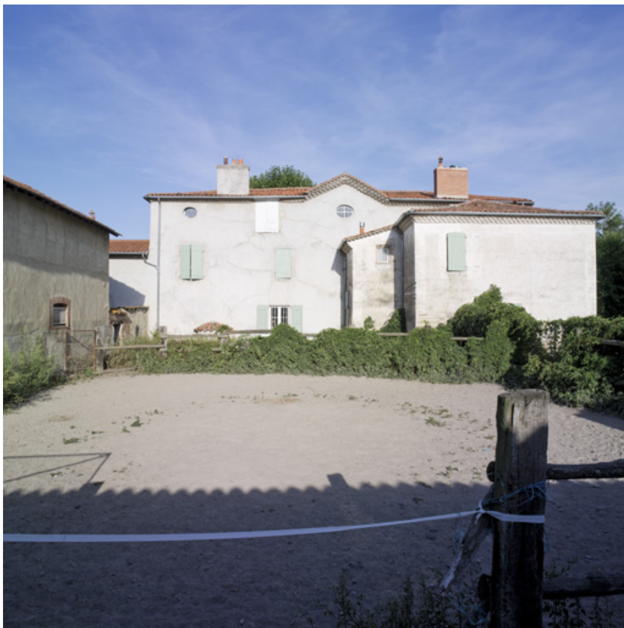
Vue arrière (ouest) de la demeure.
