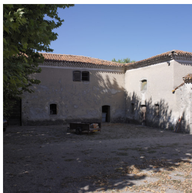
Vue intérieure de la cour de la demeure, depuis le sud-ouest. Phot. Didier Gourbin IVR82_20054202065NUCA
