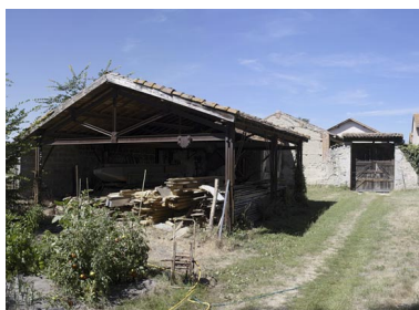
Vue de l'atelier, depuis l'ouest (au fond, portail vers la cour de la ferme voisine). Phot. Didier Gourbin IVR82_20054202055NUCAQ
