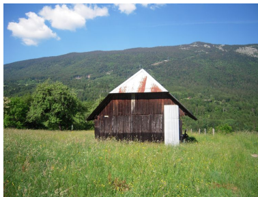
Vue d'une grange de prairie. Phot. Clémence Serve IVR82_20117403555NUCA
