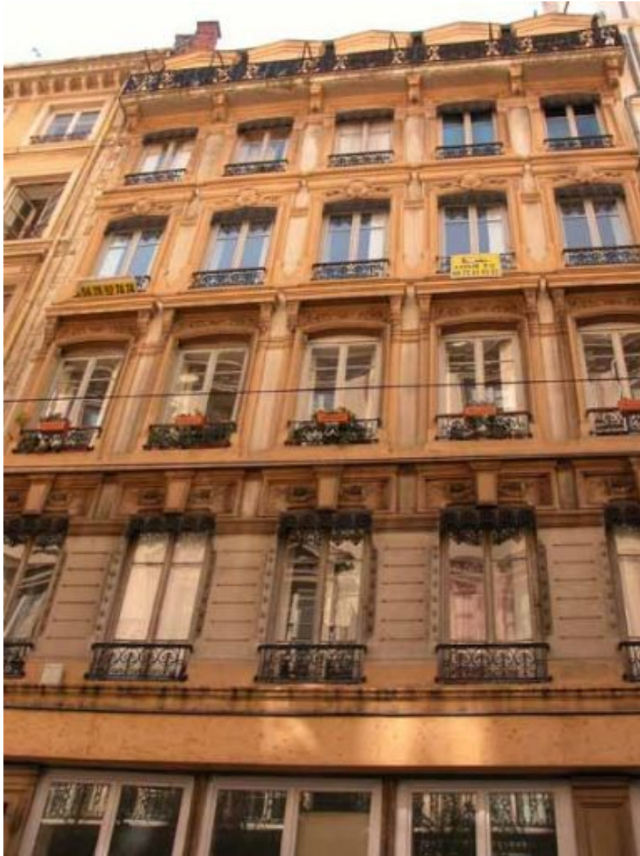
Façade sur rue, vue générale par-dessous
