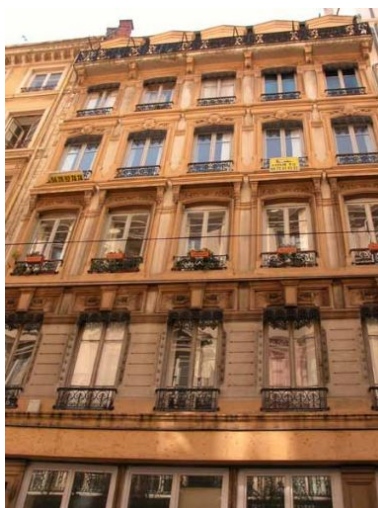
Façade sur rue, vue générale par-dessous Phot. Phot. Inv. D. Chevallier IVR82_20046900635NUCA
