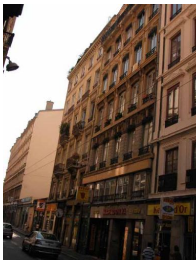
Façade sur rue, vue générale Phot. Phot. Inv. D. Chevallier IVR82_20046900634NUCA
