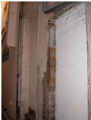
Façade sur l'impasse, détail de la porte murée au rez-de-chaussée Phot. Bernard Ducouret IVR82_20046900637NUCA
