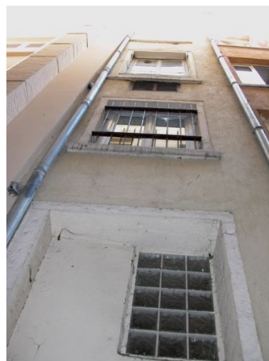
Façade sur l'impasse, vue générale par-dessous Phot. Bernard Ducouret IVR82_20046900636NUCA
