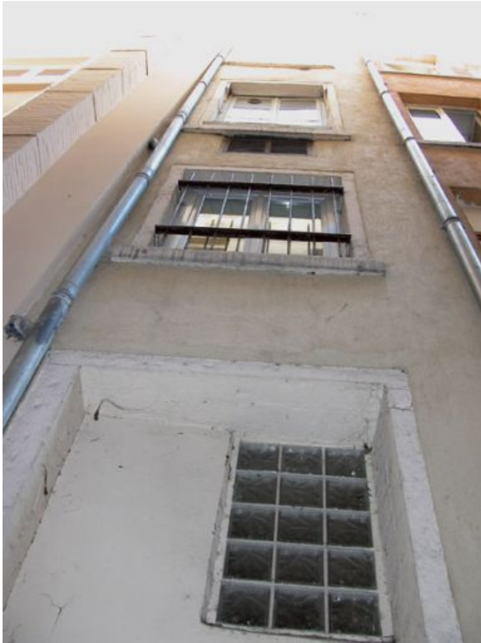
Façade sur l'impasse, vue générale par-dessous
