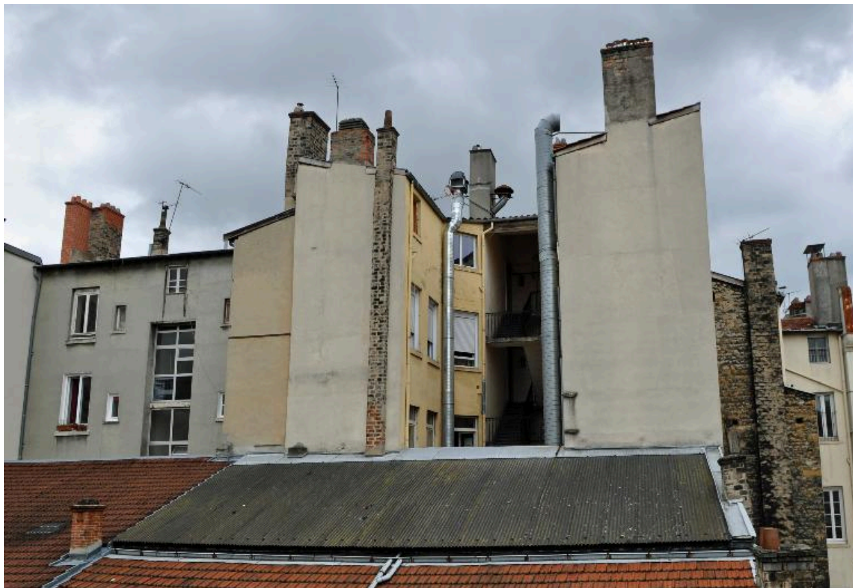
Vue partielle de l'élévation sur cour : escalier anciennement ouvert
