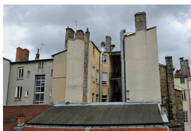
Vue partielle de l'élévation sur cour : escalier anciennement ouvert Phot. Catherine Guégan IVR82_20156901014NUCA
