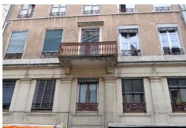
Premier étage en entresol et deuxième étage privilégié, avec balcon central Phot. Catherine Guégan IVR82_20156901003NUCA
