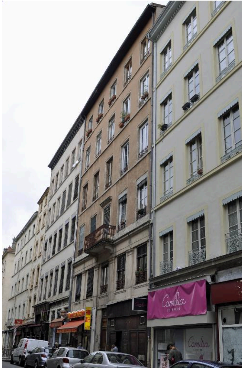
Vue générale de l'élévation sur rue
