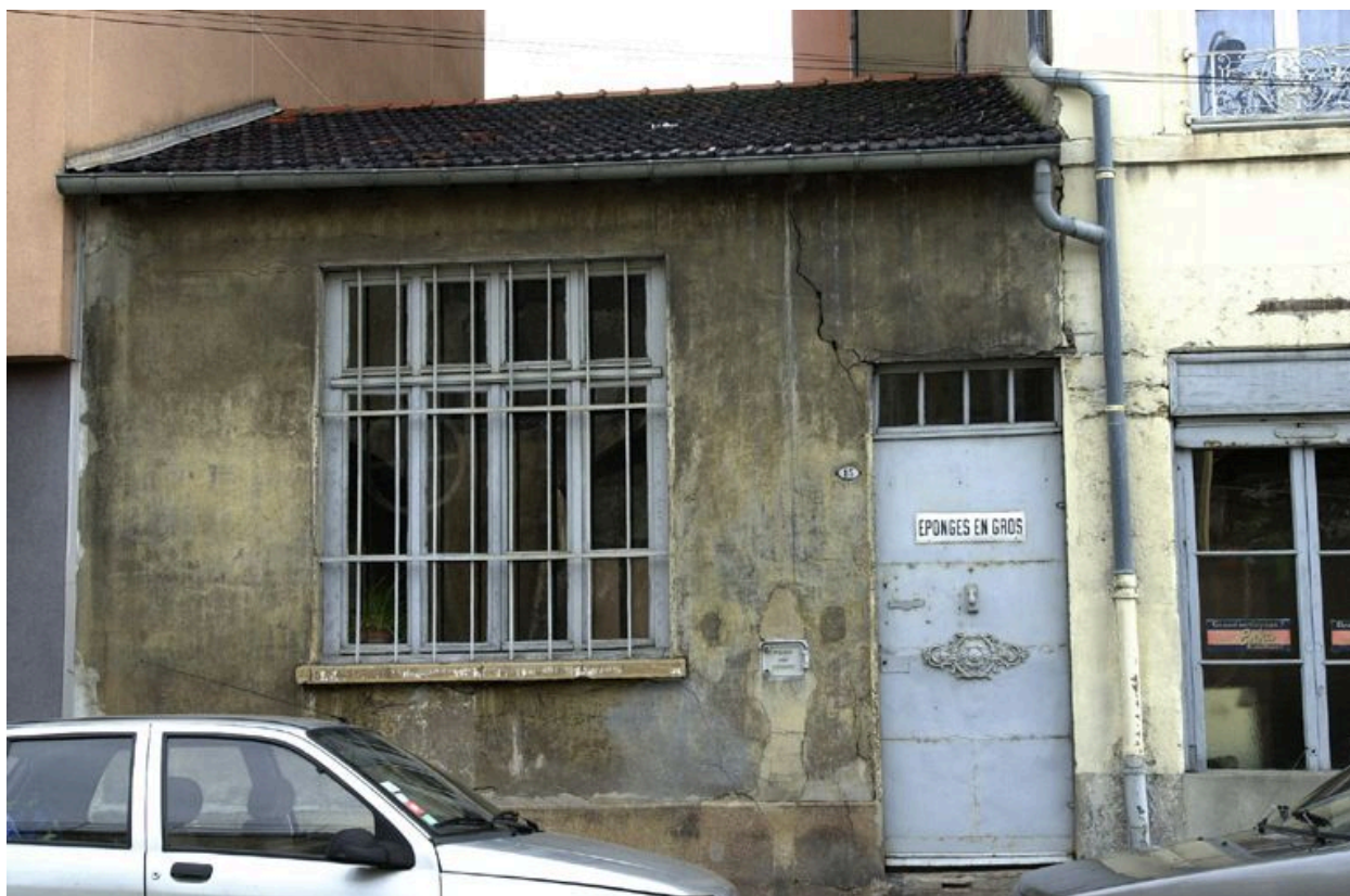
Vue de la façade ouest
