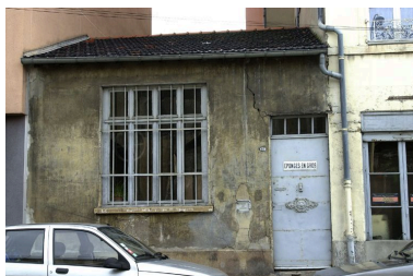
Vue de la façade ouest Phot. Nadine Halitim-Dubois IVR82_20016900276NUCA
