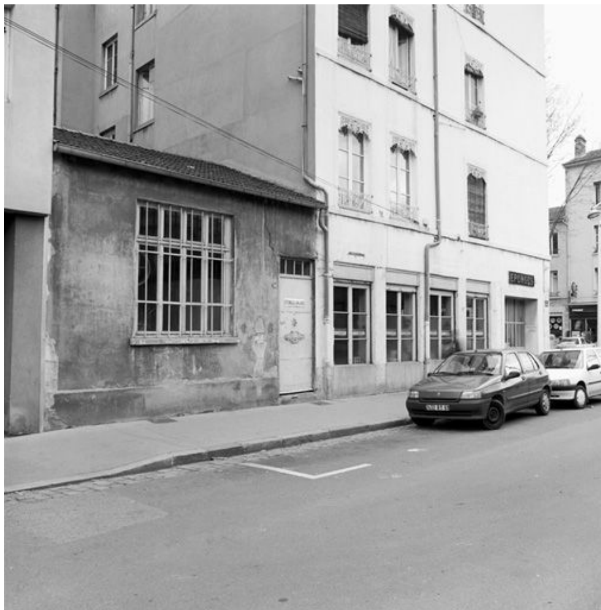
Façade rue Gilibert, partie atelier
