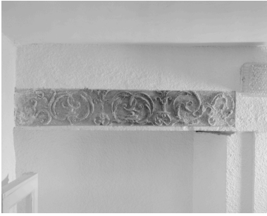
Bâtiment d'entrée. Premier étage. Linteau orné d'une frise végétale. Phot. Alain Franchella IVR82_19982600670X
