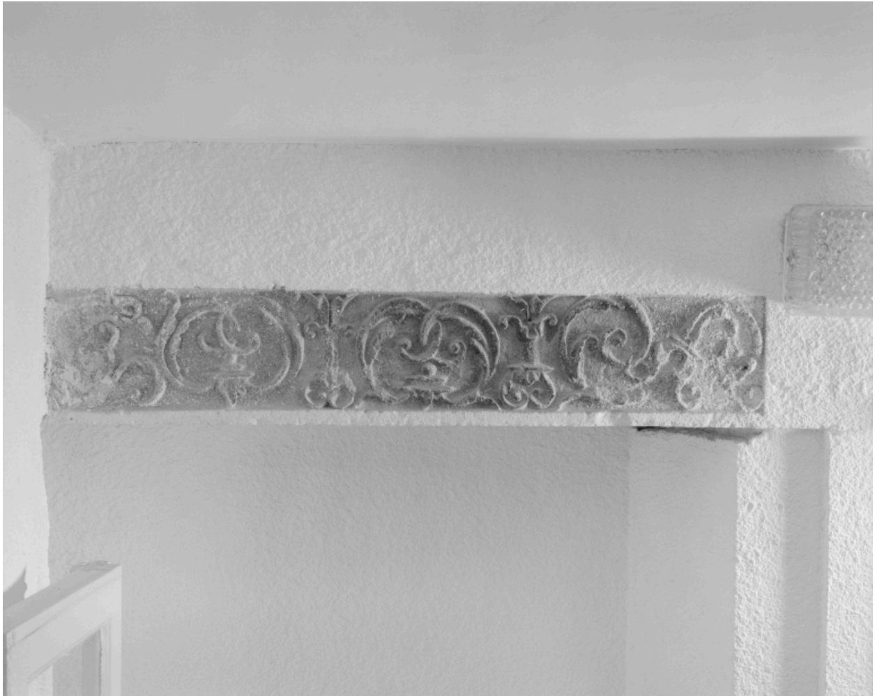
Bâtiment d'entrée. Premier étage. Linteau orné d'une frise végétale.
