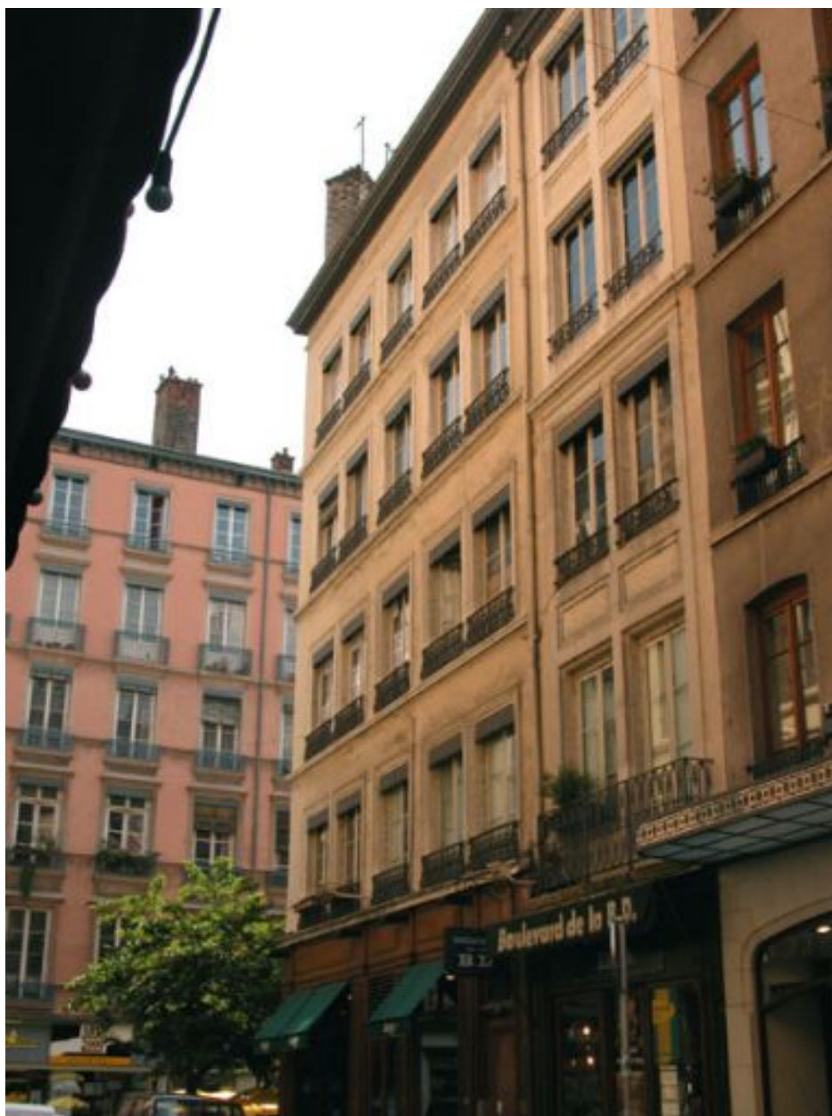
Immeuble commencé en 1858, façade sur rue
