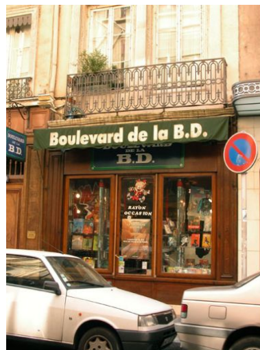
Immeuble de 1856, façade sur rue, 1er niveau Phot. Bernard Ducouret IVR82_20046900688NUCA
