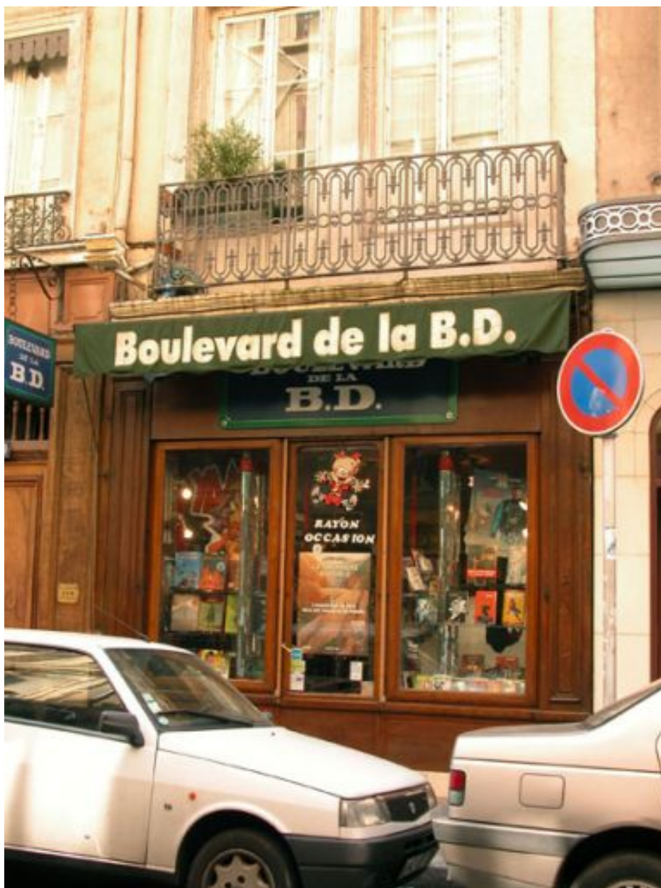
Immeuble de 1856, façade sur rue, 1er niveau
