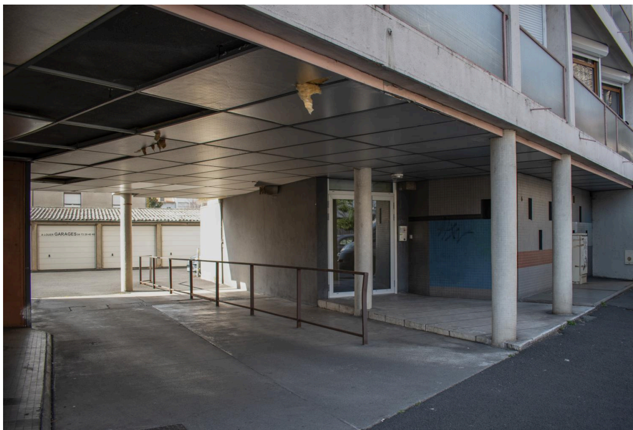
Passage vers les garages de la cour intérieure
