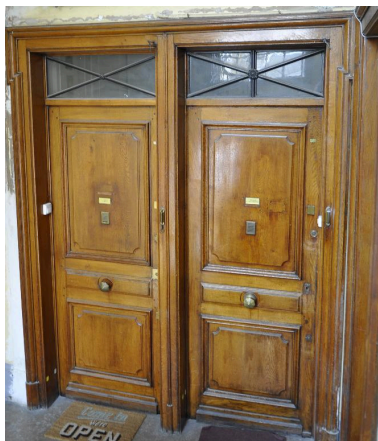
Vue intérieure : portes palières Phot. Catherine Guégan IVR82_20156901027NUCA
