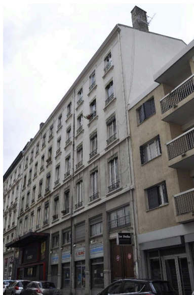
Vue d'ensemble des deux immeubles jumelés Phot. Catherine Guégan IVR82_20156901022NUCA
