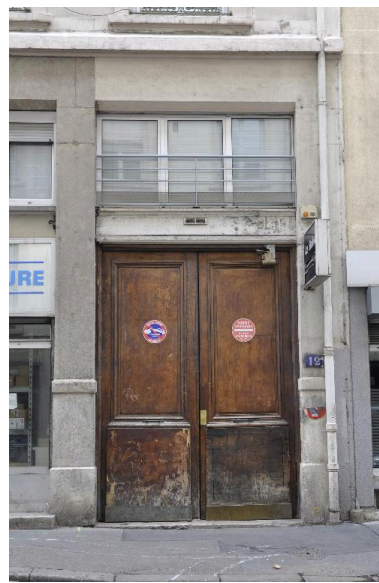
Elévation sur rue : porte cochère, entresol Phot. Catherine Guégan IVR82_20156901024NUCA
