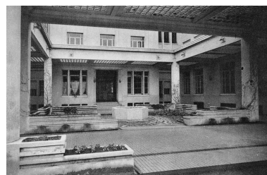
La cour d'Entrée Repro. Jean-Marie Refflé IVR82_20026902314XB
