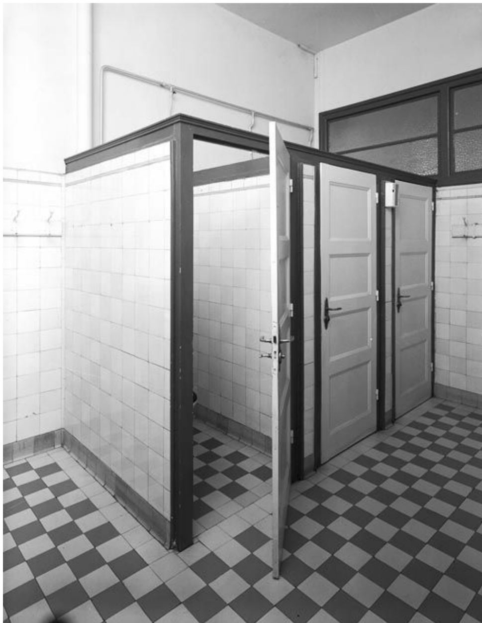
Aile occidentale, toilettes du rez-de-chaussée
