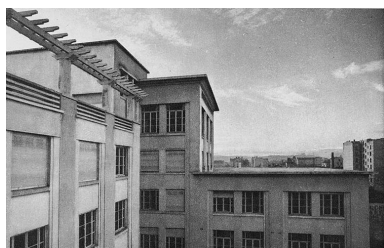
L'Ecole - Vue sur la colline de Fourvière prise d'une terrasse Repro. Jean-Marie Refflé IVR82_20026902318XB
