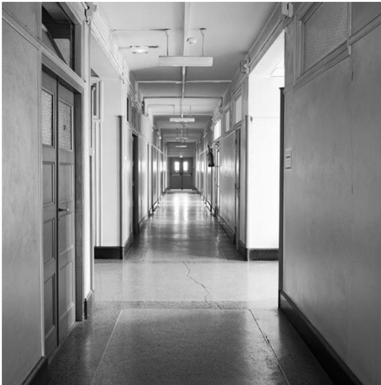
Aile occidentale, 2e étage, vue d'ensemble du couloir en direction de l'arrière du bâtiment
