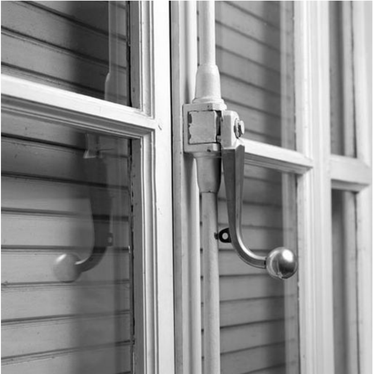
Salle de réunion, détail d'une poignée de fenêtre
