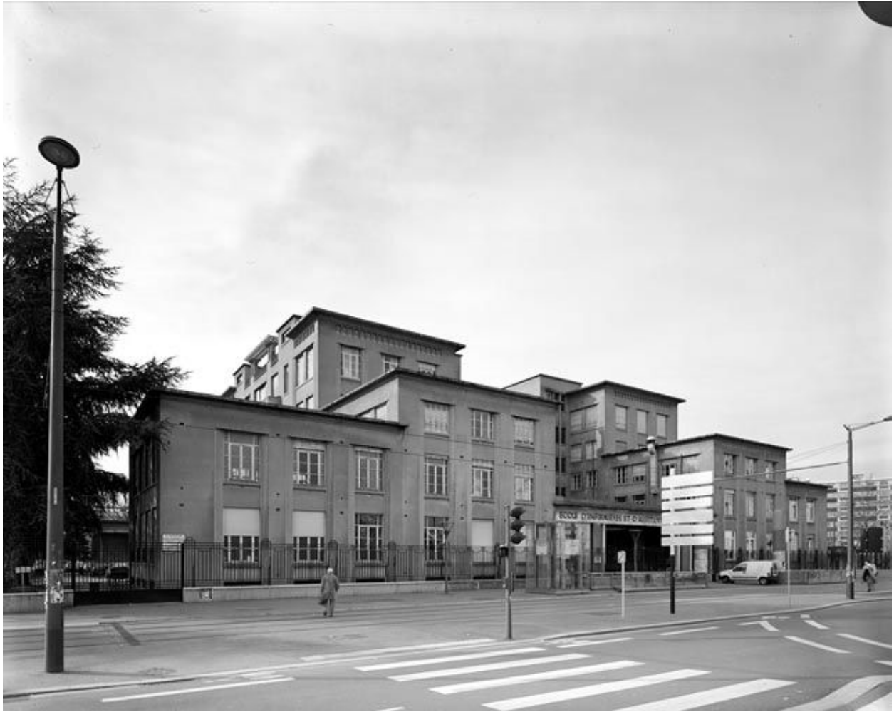
Vue générale du côté de l'entrée principale
