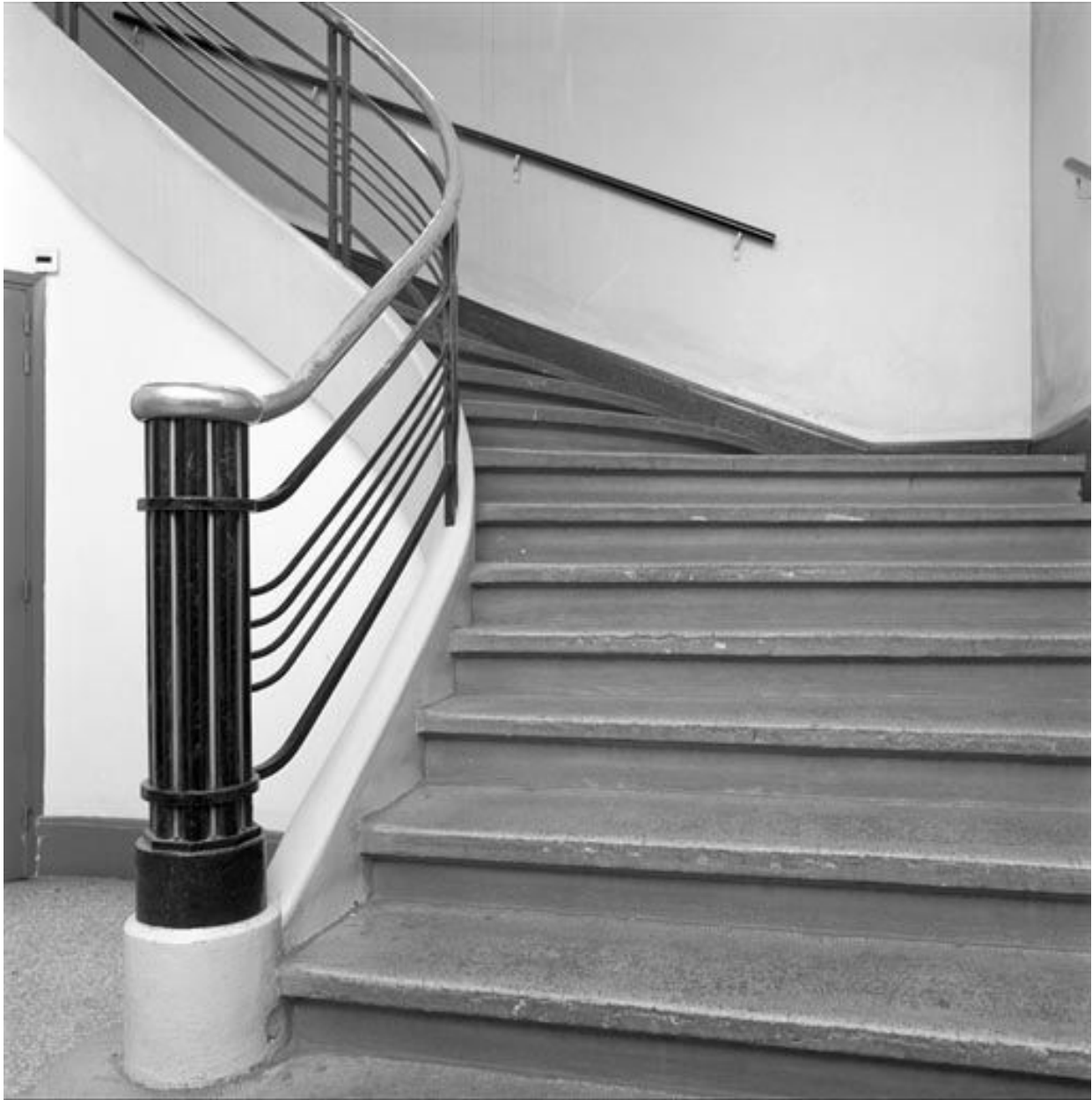
Escalier est, palier du rez-de-chaussée, départ de la rampe
