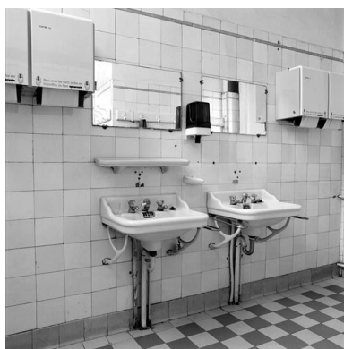
Aile occidentale, toilettes du rez-de-chaussée, détail des lavabos Phot. Eric Dessert IVR82_20026902353X
