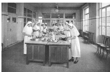
La cuisine diététique Repro. Jean-Marie Refflé IVR82_20026902328XB
