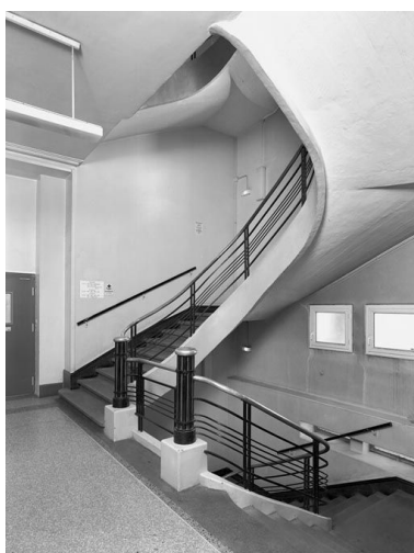
Escalier ouest vu du palier du rez-de-chaussée Phot. Eric Dessert IVR82_20026902341V
