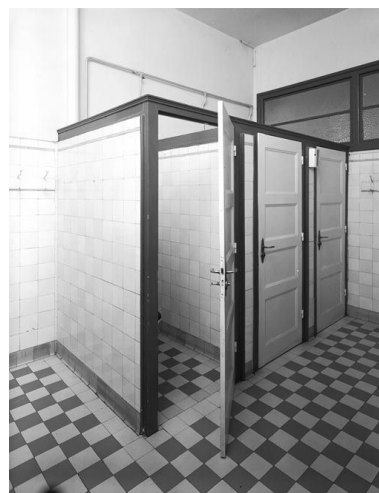
Aile occidentale, toilettes du rez-de-chaussée Phot. Eric Dessert IVR82_20026902352V
