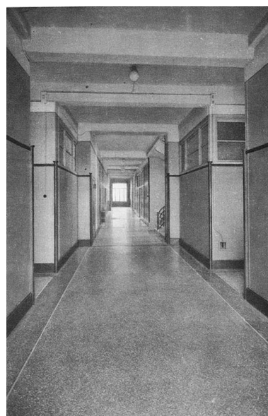
Un grand couloir Repro. Jean-Marie Refflé IVR82_20026902326XB
