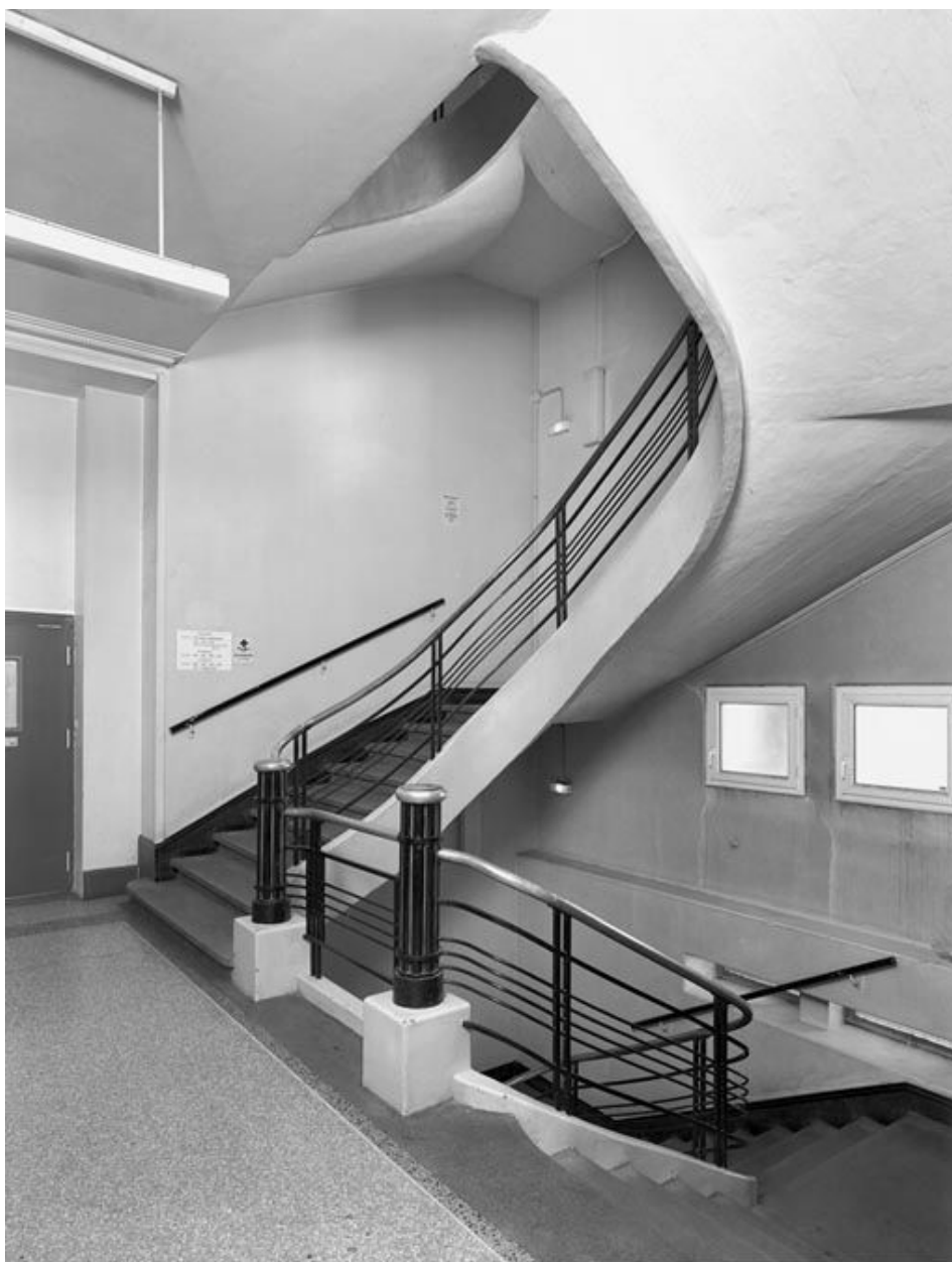
Escalier ouest vu du palier du rez-de-chaussée
