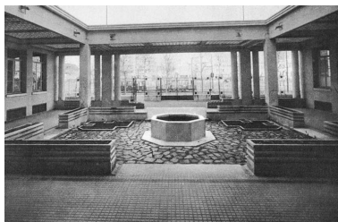
La cour d'Entrée Repro. Jean-Marie Refflé IVR82_20026902316XB
