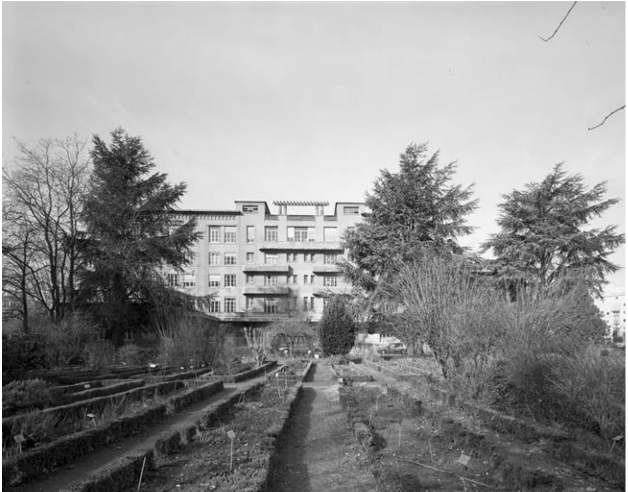
Vue générale côté est, depuis le jardin botanique voisin
