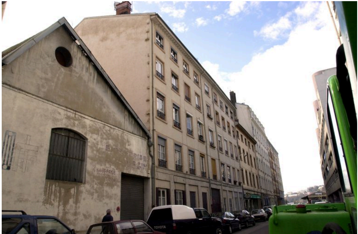
Vue d' l'immeuble sur sur
