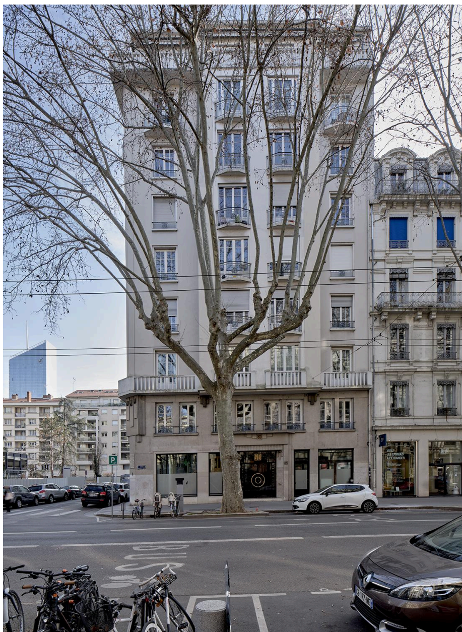
Vue d'ensemble, élévation sur l'avenue de Saxe
