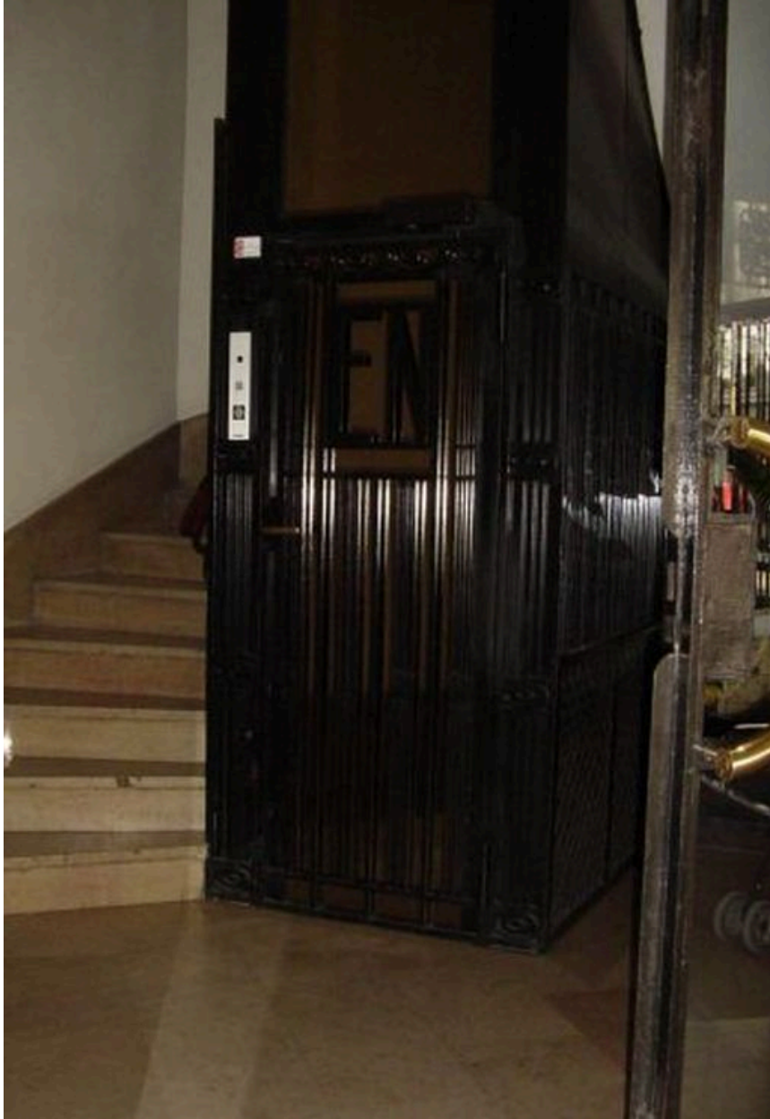
Ascenseur et départ de l'escalier
