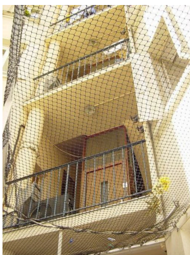
Façade postérieure et ascenseur de service Phot. Anaïs Beccaria IVR82_20046903603NUCA
