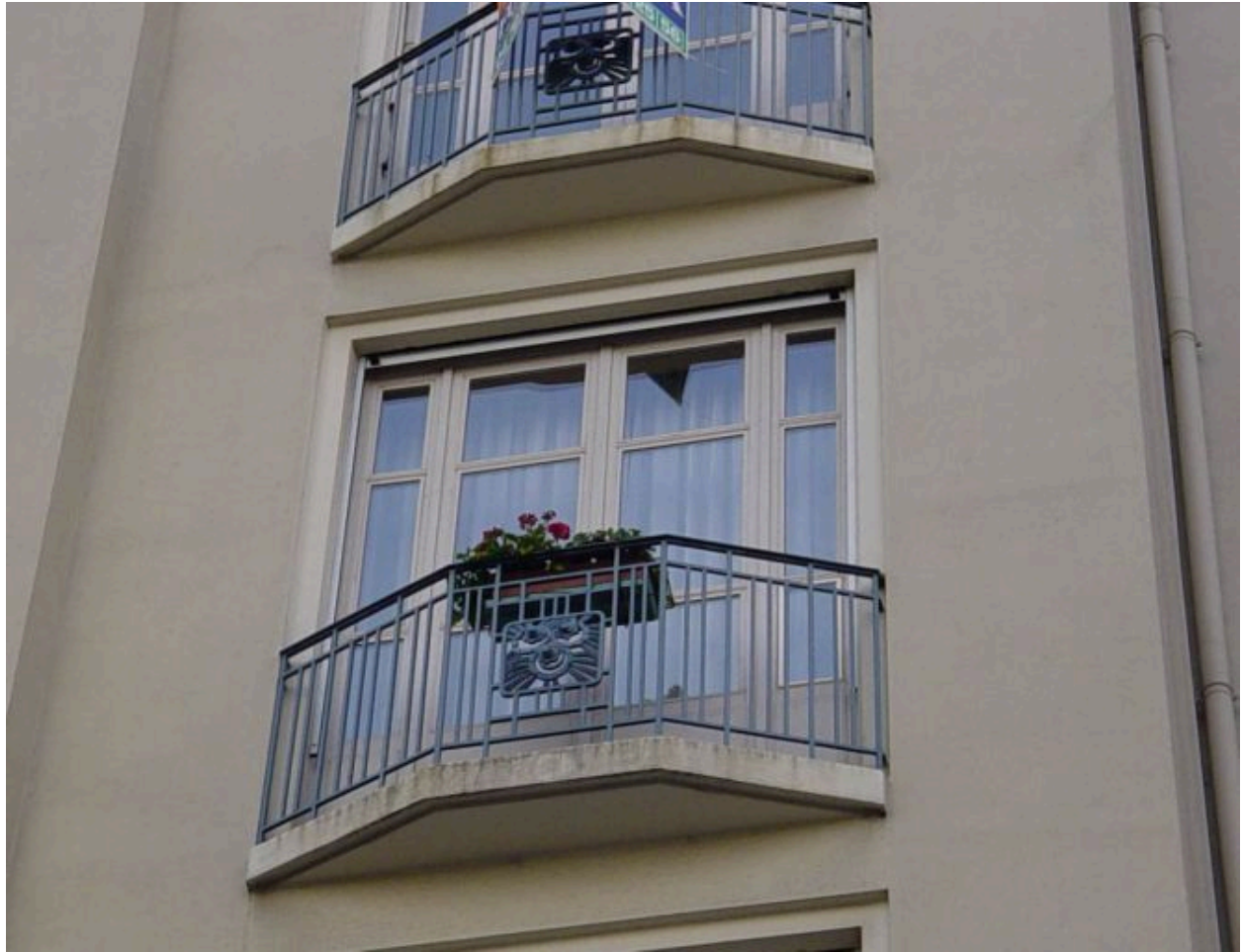
Balcons (rue Dunoir)
