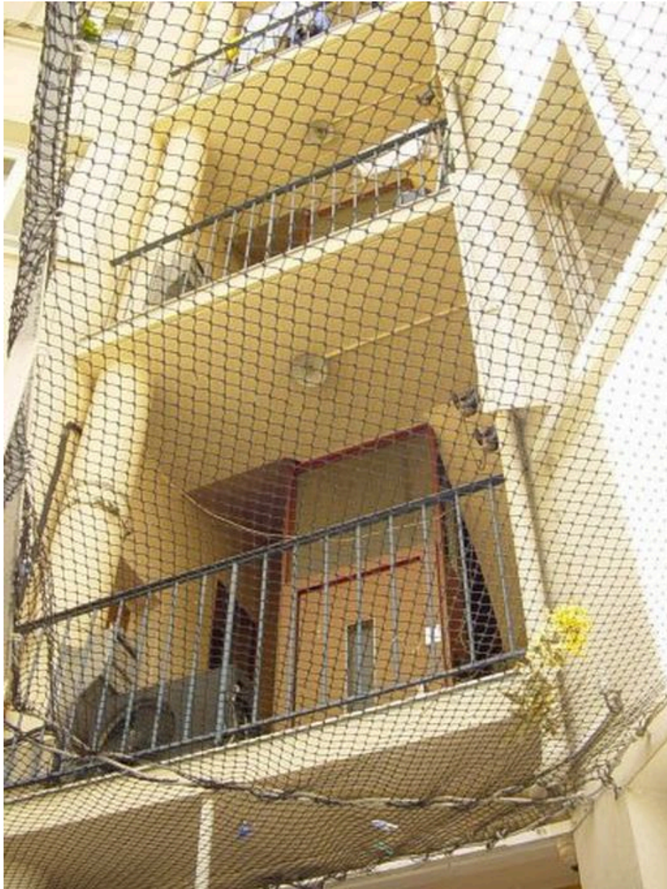
Façade postérieure et ascenseur de service
