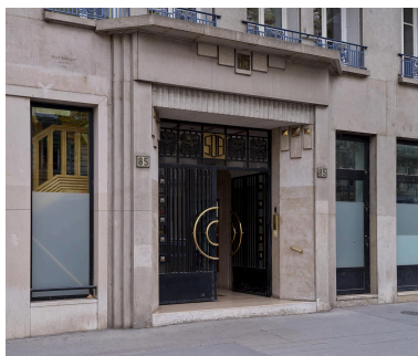
Vue rapprochée de la porte Phot. Franck Trabouillet IVR84_20226901696NUCA
