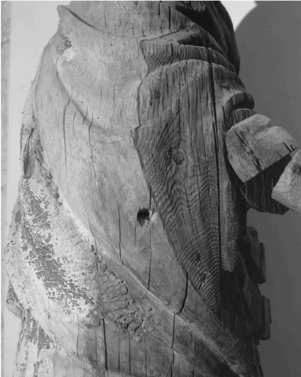
Détail d'assemblage et vestiges d'apprêt doré.
