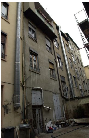
Elévation postérieure, depuis la cour AY 26 Phot. Maryannick Chalabi IVR82_20016900226NUCA
