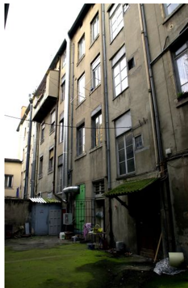
Elévation postérieure depuis la cour AY 28 Phot. Maryannick Chalabi IVR82_20016900227NUCA
