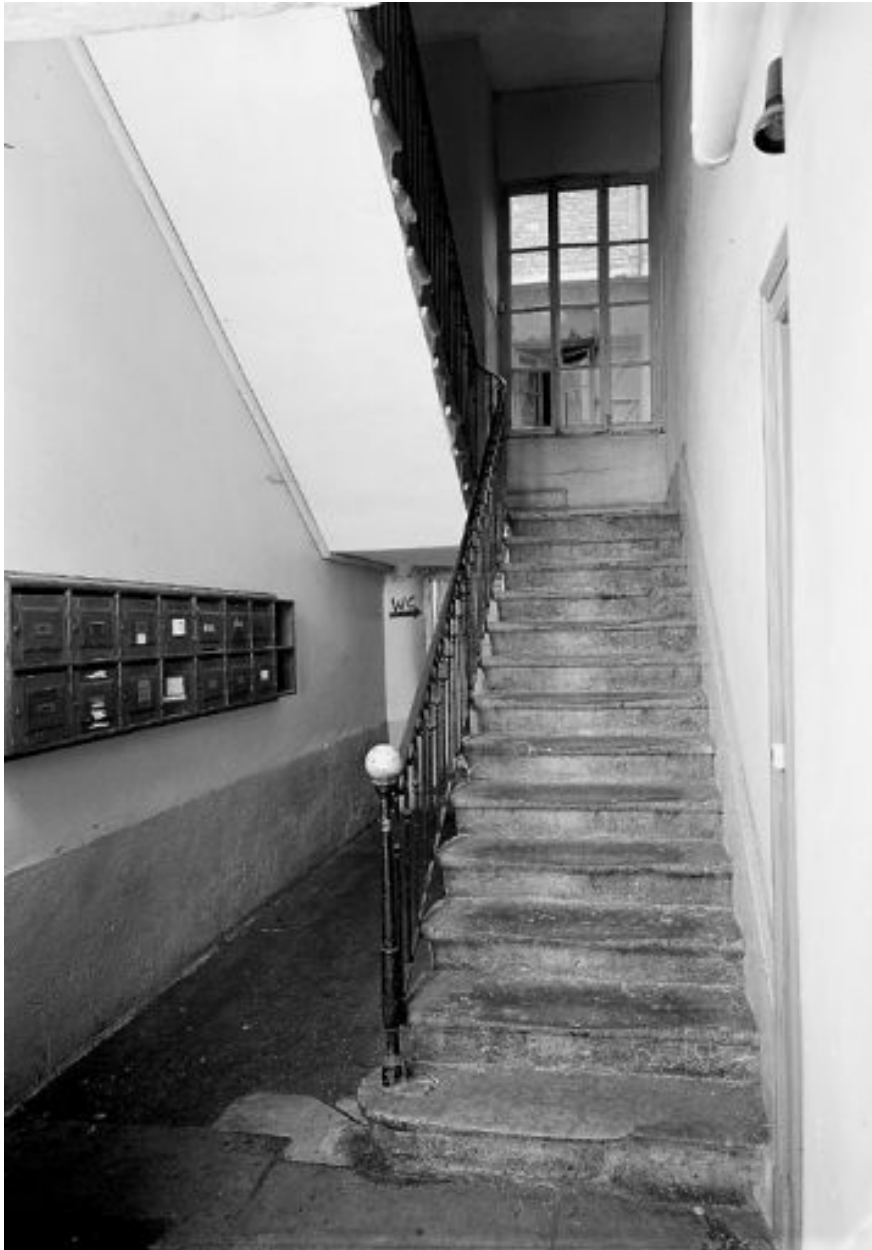
Vue de la montée d'escalier
