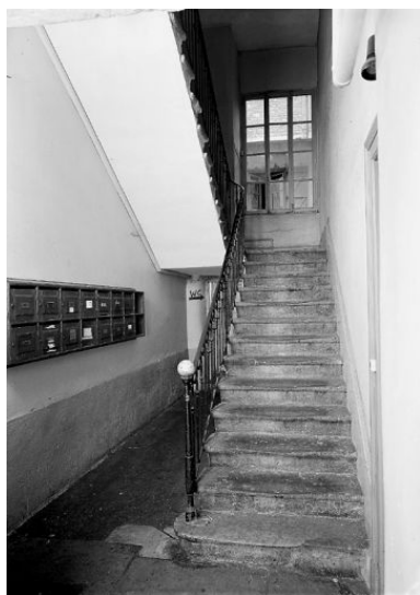
Vue de la montée d'escalier Phot. Jean-Marie Refflé IVR82_20016901768P
