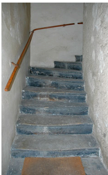
Première volée de l'escalier commun vue depuis le nord Phot. Maryannick Chalabi IVR82_20066901370NUCA
