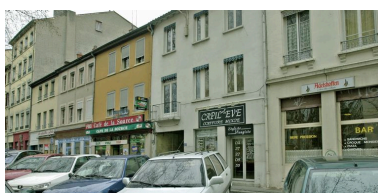
Façades en commun des immeubles n°45 à 35 rue Claude- Boyer vue depuis le sud-ouest Phot. Maryannick Chalabi IVR82_20066901240NUCA
