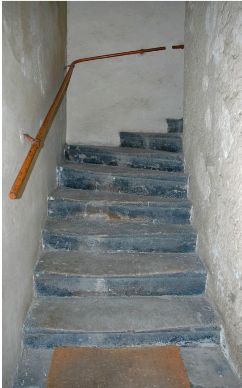
Première volée de l'escalier commun vue depuis le nord
