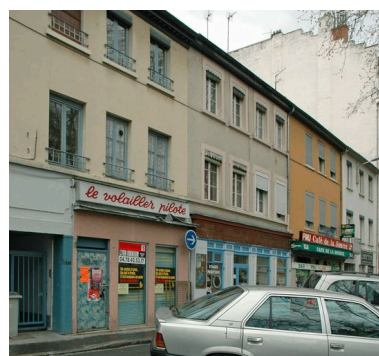
Façade sur la rue Claude Boyer vue depuis le nord-est Phot. Maryannick Chalabi IVR82_20066901372NUCA
