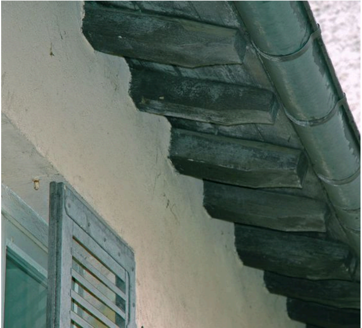
Solives de l'avant-toit sur cour, vues depuis la baie de la cage d'escalier au sud
