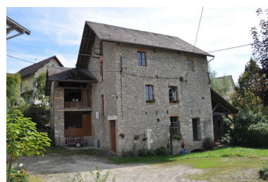
Façade nord-ouest et nord Phot. Yannick Milleret IVR82_20097300252NUCA
