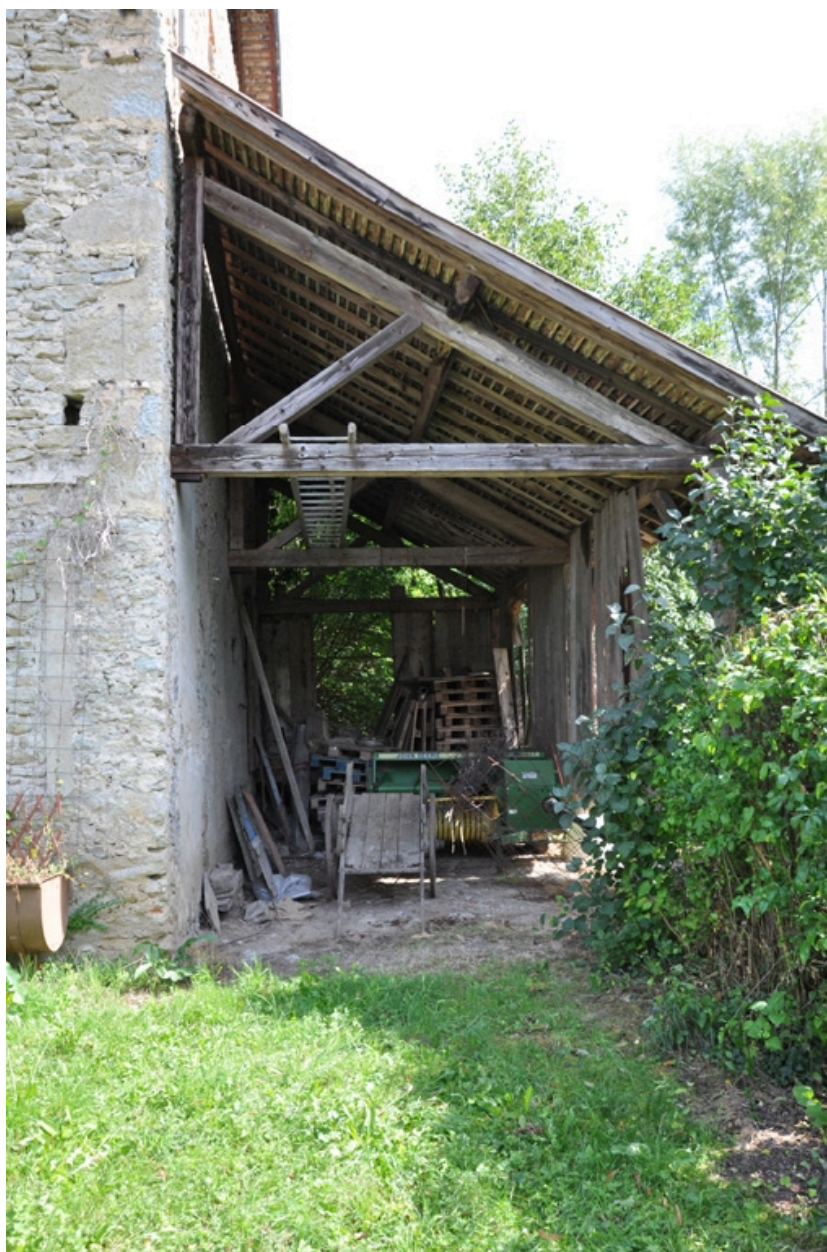
Avant-toit sur la façade sud-ouest à l'emplacement de l'ancienne meule
