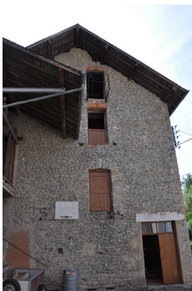
Façade nord du moulin Phot. Yannick Milleret IVR82_20097300257NUCA
