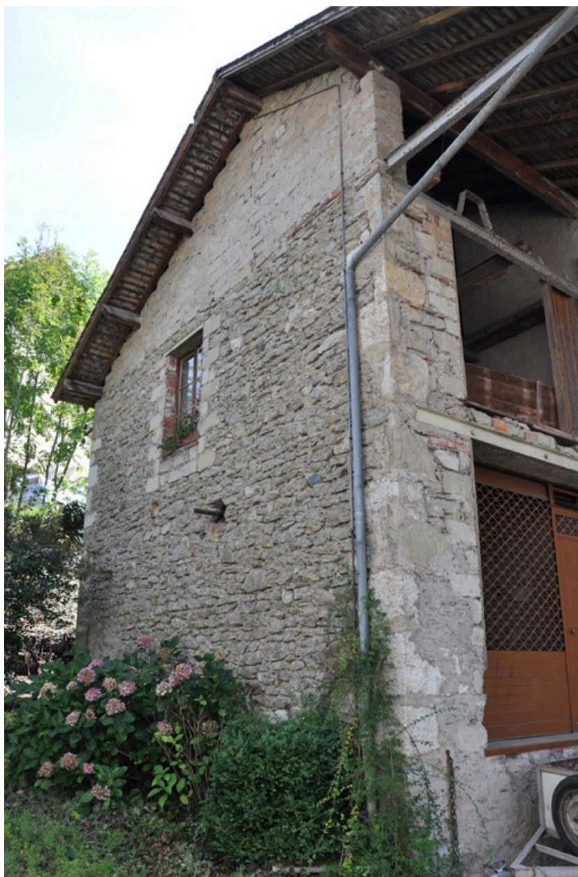
Façade nord de l'extension du moulin consacrée au nettoyage
