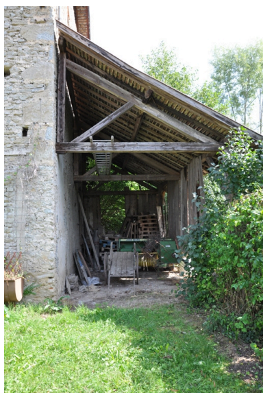
Avant-toit sur la façade sud-ouest à l'emplacement de l'ancienne meule Phot. Yannick Milleret IVR82_20097300258NUCA
