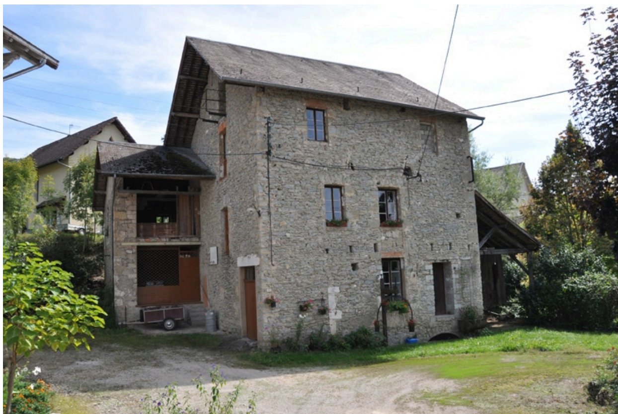
Façade nord-ouest et nord
