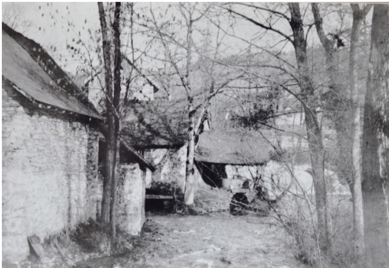
Carte postale ancienne du moulin Berthier, vue aval, avant son agrandissement
