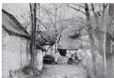
Carte postale ancienne du moulin Berthier, vue aval, avant son agrandissement Phot. Yannick Milleret IVR82_20097300250NUCA
