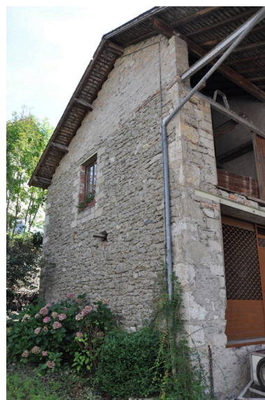
Façade nord de l'extension du moulin consacrée au nettoyage Phot. Yannick Milleret IVR82_20097300256NUCA
