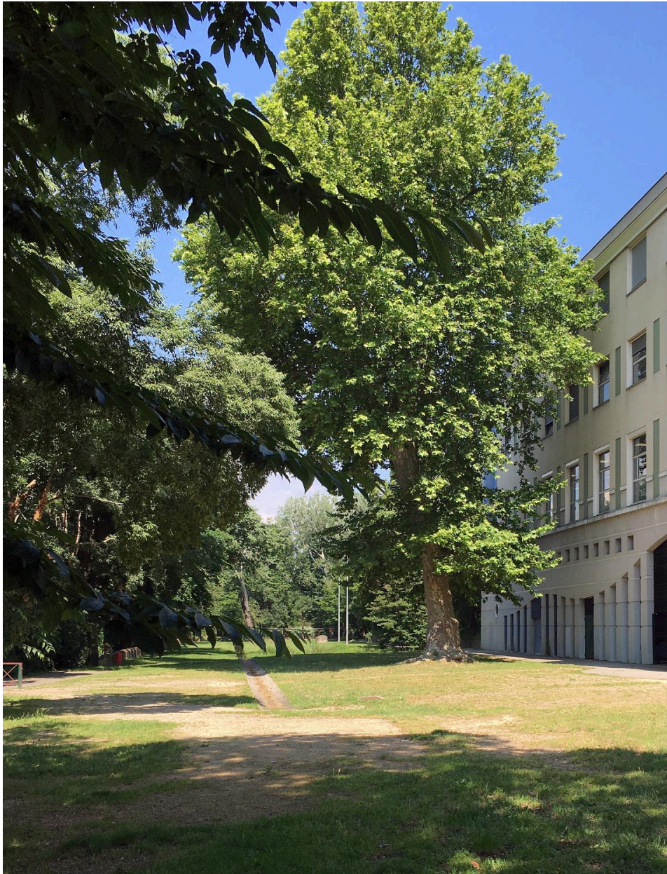
Installation,, partie ouest
