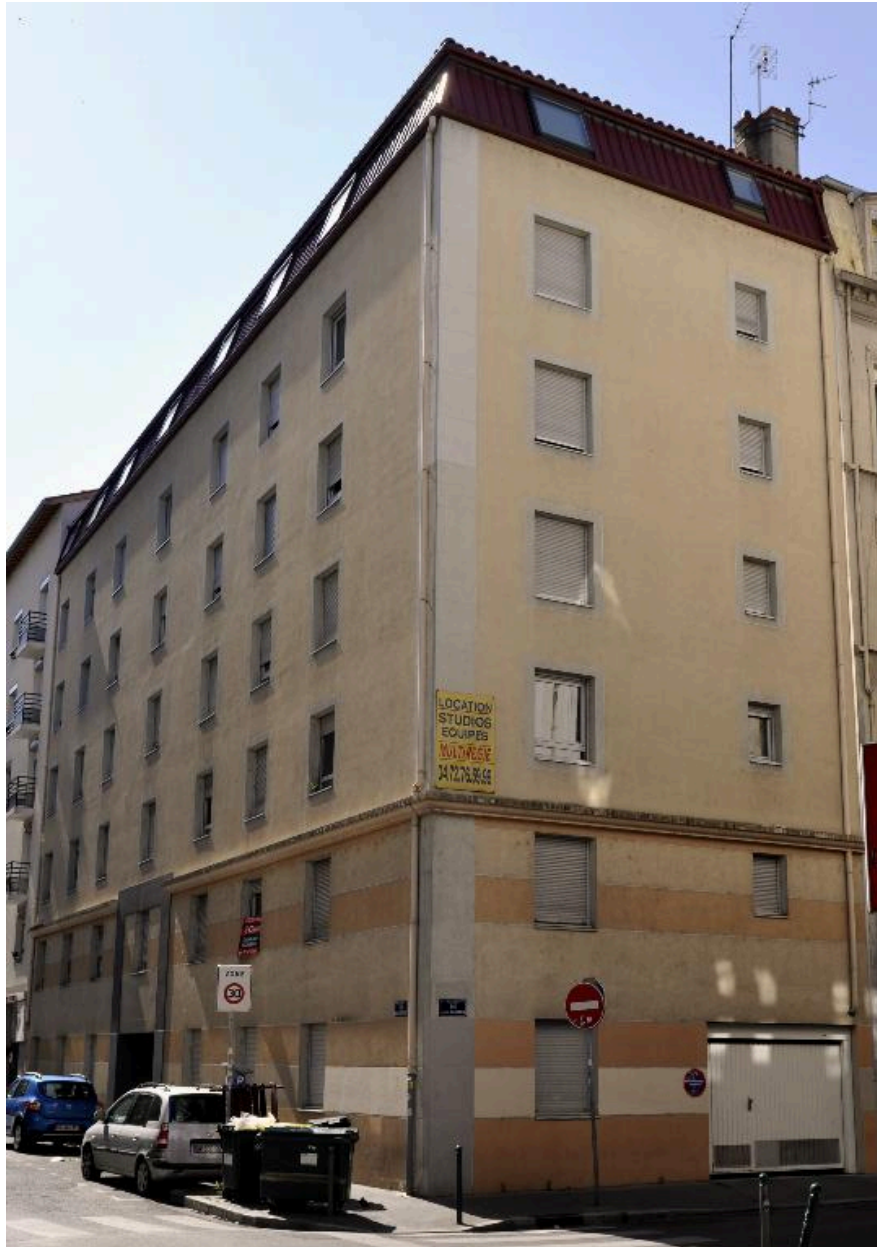
Vue générale depuis la rue Pasteur
