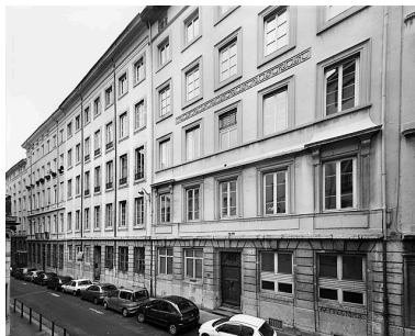
Vue générale de la rue Royale nord-est Phot. Didier Gourbin IVR82_20046902980V
