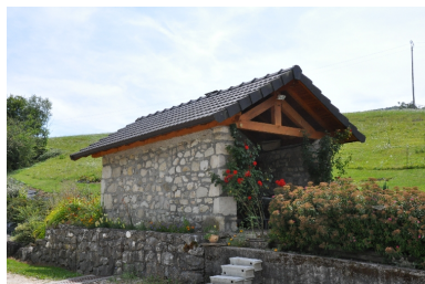
Vue de four à pain restauré Phot. Yannick Milleret IVR82_20117302118NUCA
