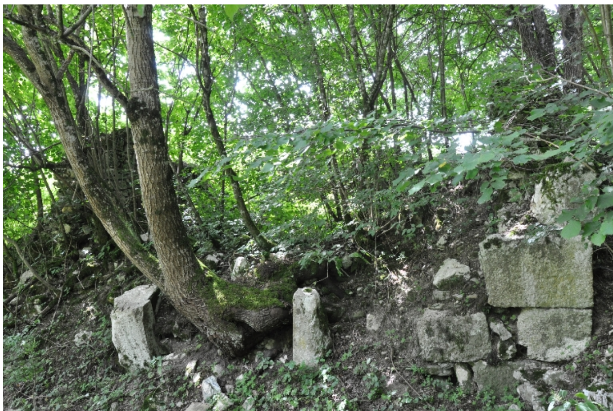
Vue générale des vestiges du moulin envahi par la végétation
