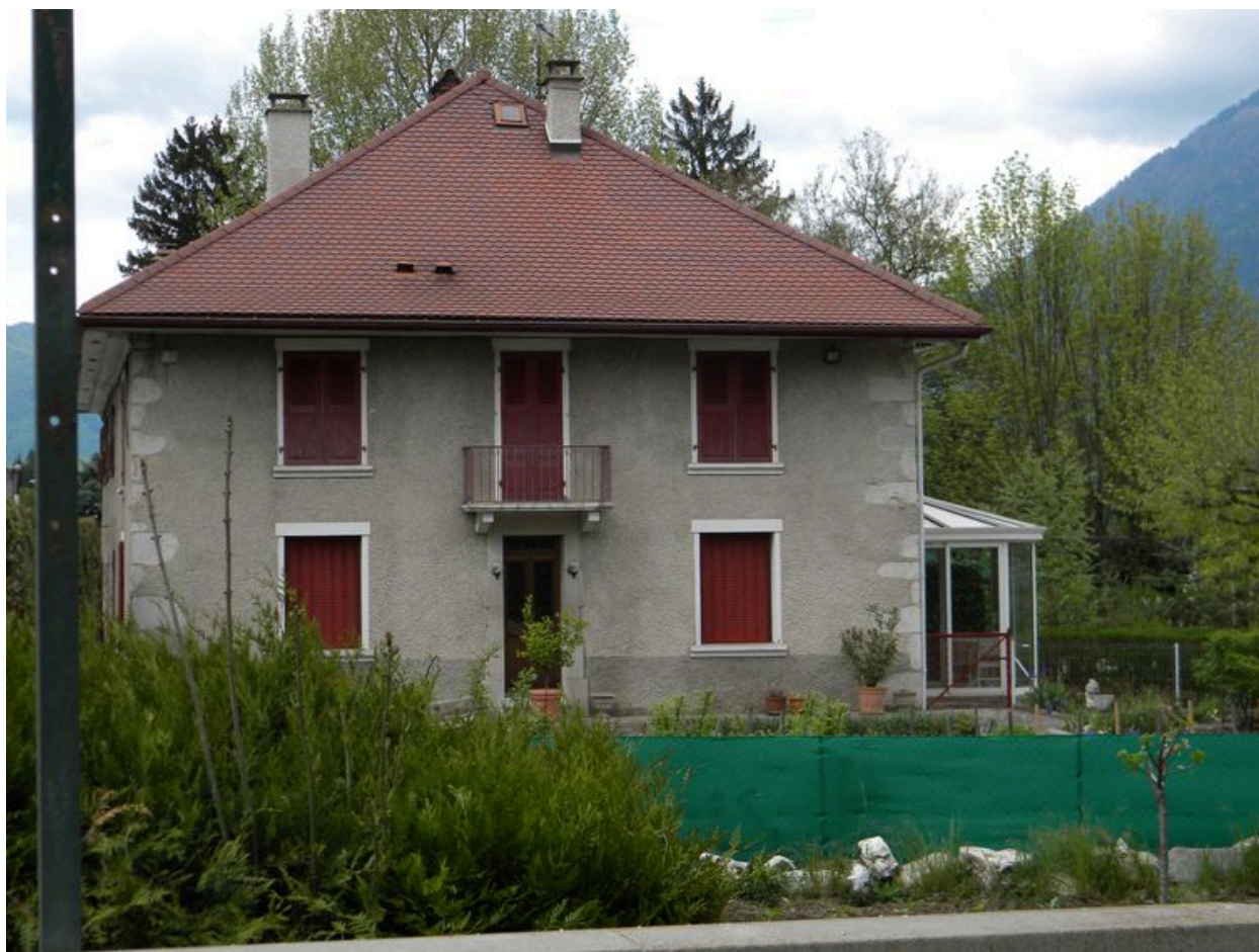
Vue du mur pignon sud.
