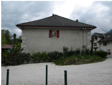
Vue du mur pignon nord. Phot. Jérôme Daviet IVR82_20117400511NUCA
