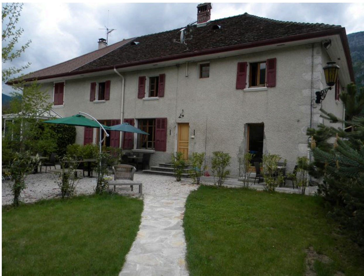
Vue de la façade arrière.
