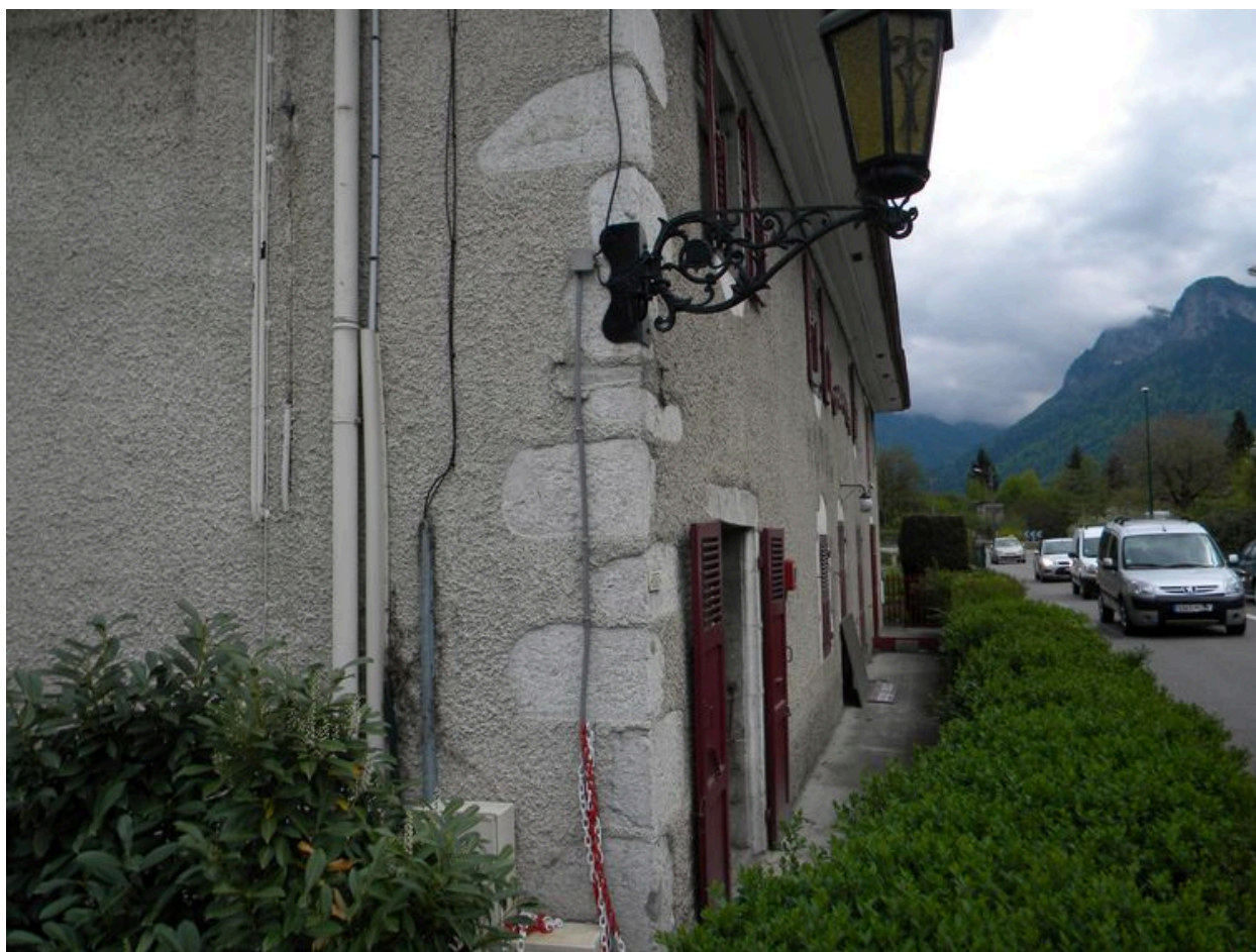
Alignement de façade et chaînage d'angle.
