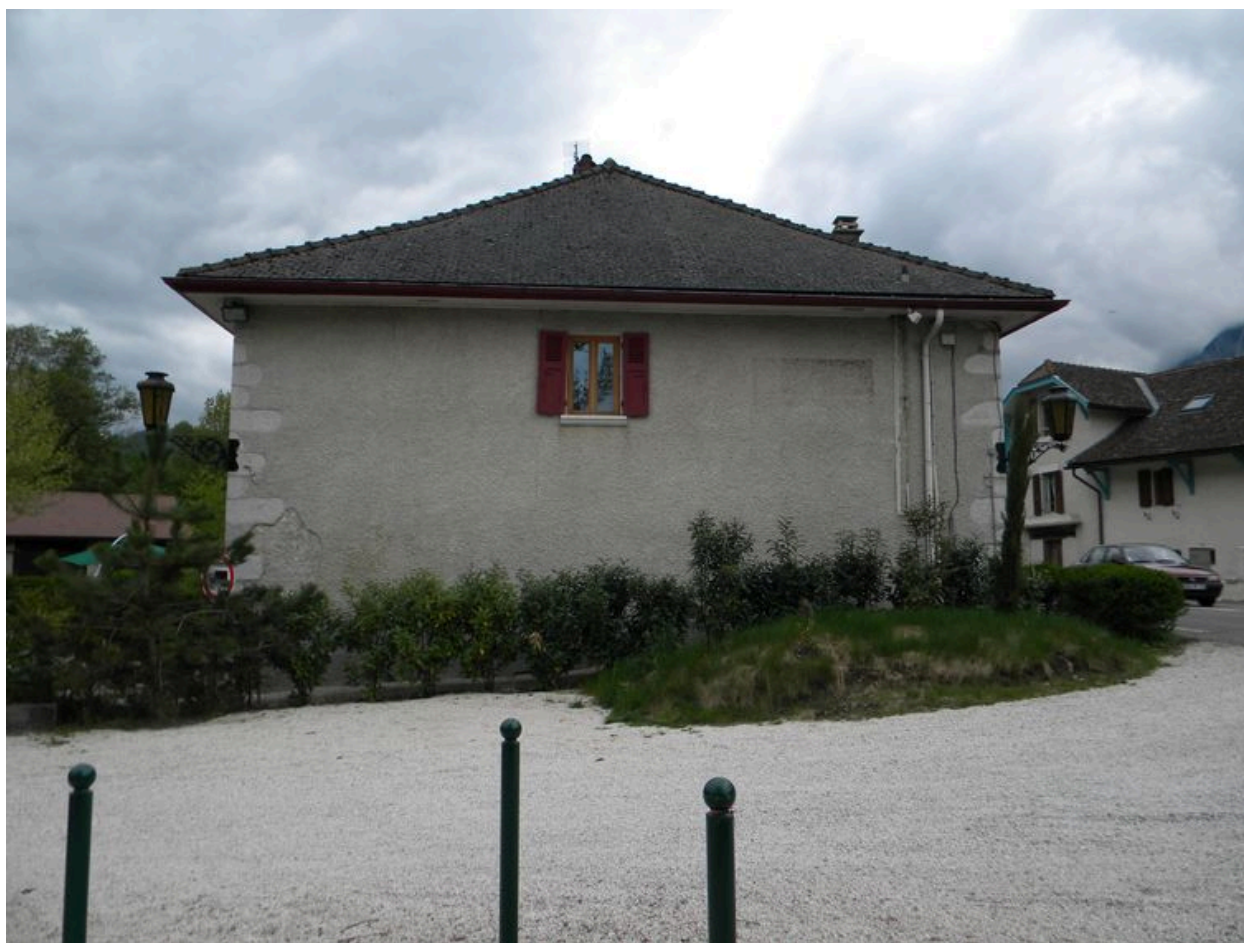
Vue du mur pignon nord.
