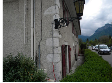
Alignement de façade et chaînage d'angle. Phot. Jérôme Daviet IVR82_20117400509NUCA
