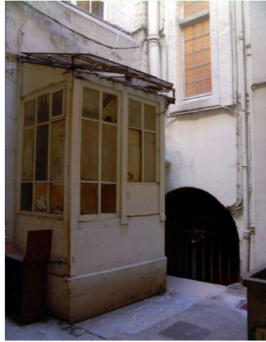
Cour intérieure : vue de la loge de concierge Phot. Bernard Ducouret IVR82_20016900917NUCA
