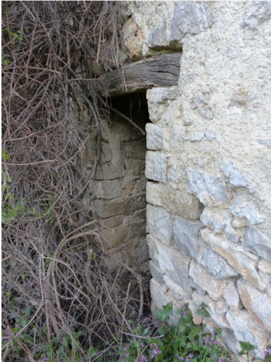
Pignon sud, premier niveau. Porte de l'étable.
