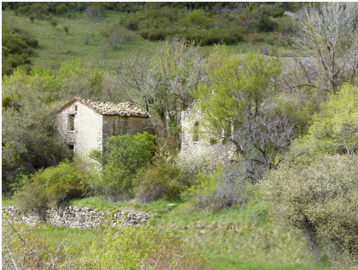
Vue de situation prise du sud-est.
