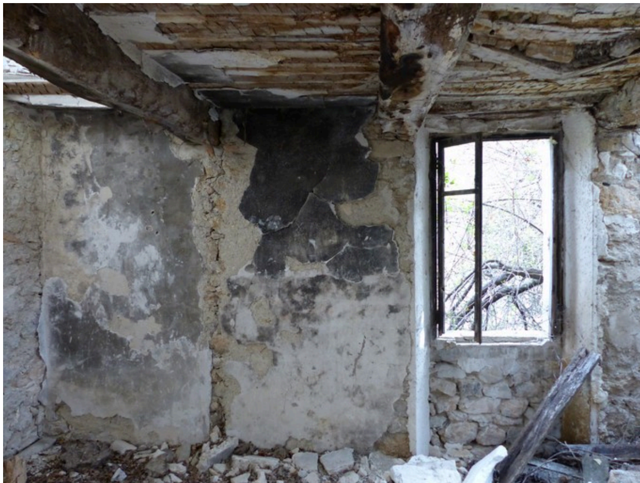
Rez-de-chaussée surélevé, logis. Mur sud.
