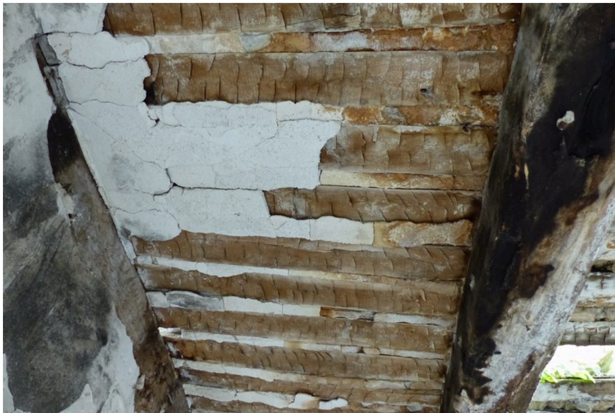
Rez-de-chaussée surélevé, logis. Vestiges du plafond enduit.
