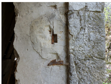
Rez-de-chaussée surélevé, logis. Mur nord, détail de l'embrasure de la porte. Phot. Alexeï Laurent IVR84_20162600820NUCA
