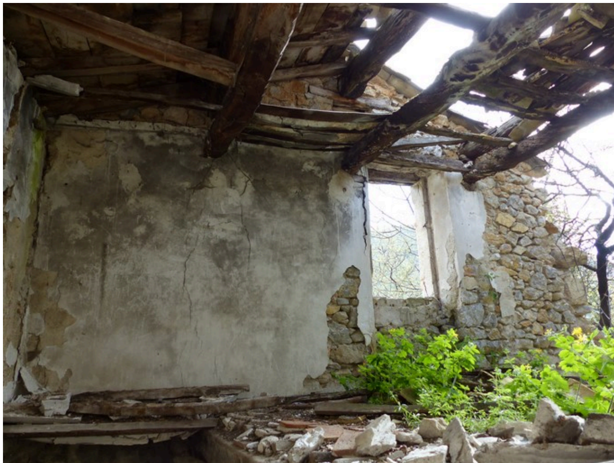
Etage, logis. Mur sud.
