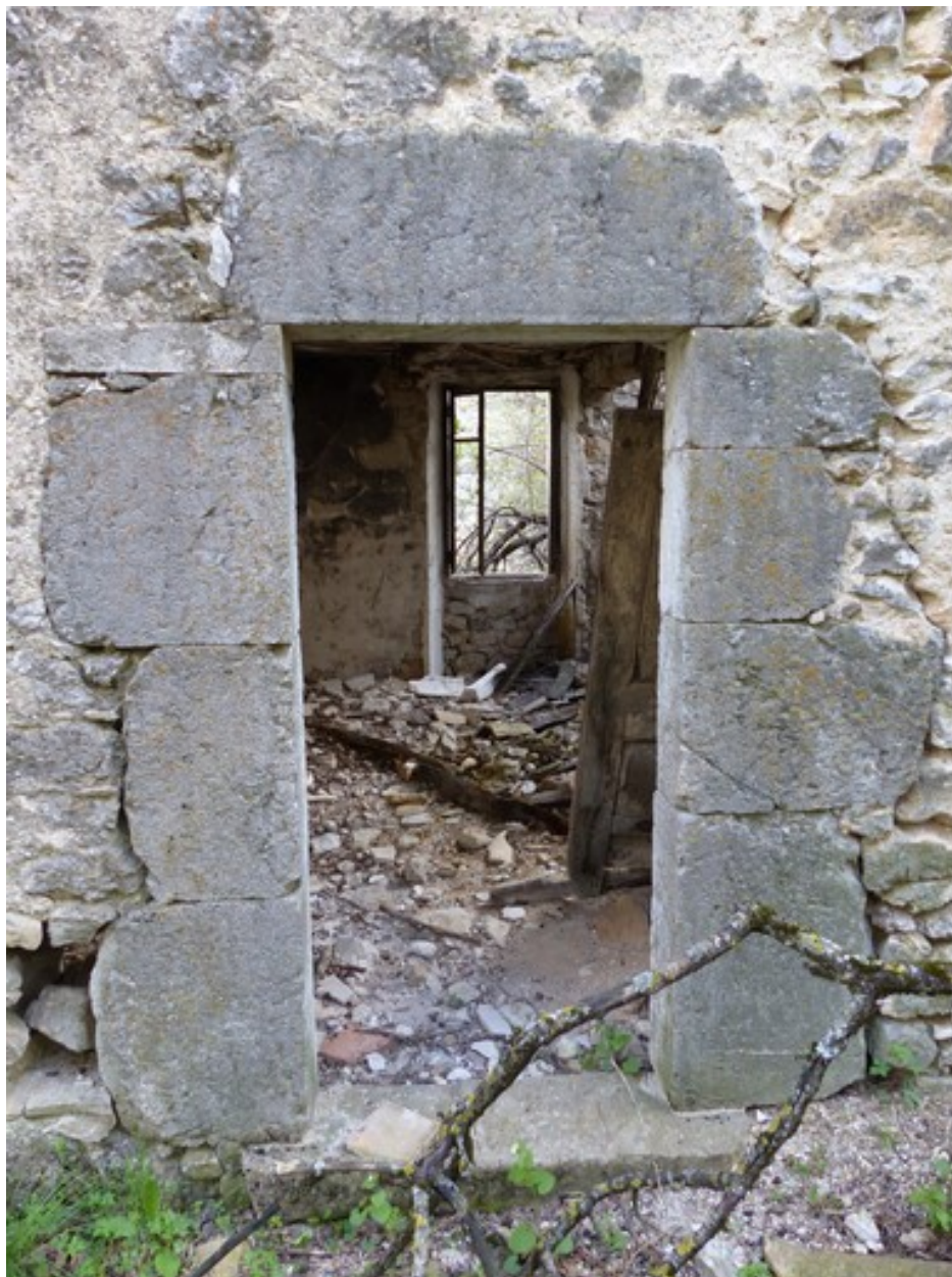
Elévation nord, premier niveau. Porte du logis.
