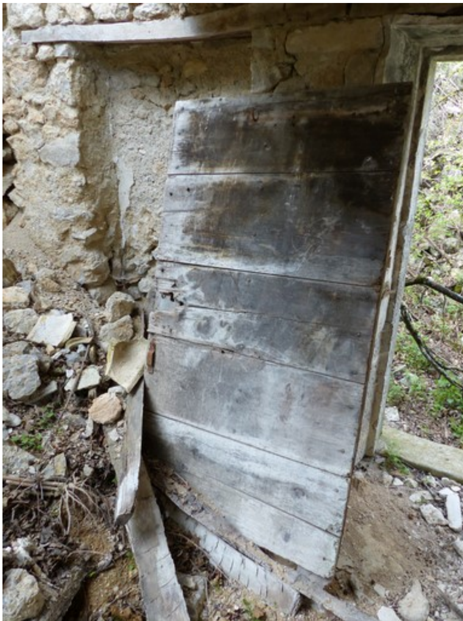
Rez-de-chaussée surélevé, logis. Mur nord, porte.
