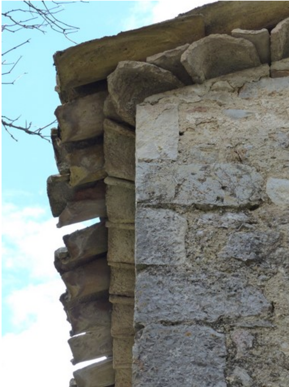
Chaîne d'angle sud-ouest, passage du rang de génoise de l'avant-toit vers la saillie de rive.
