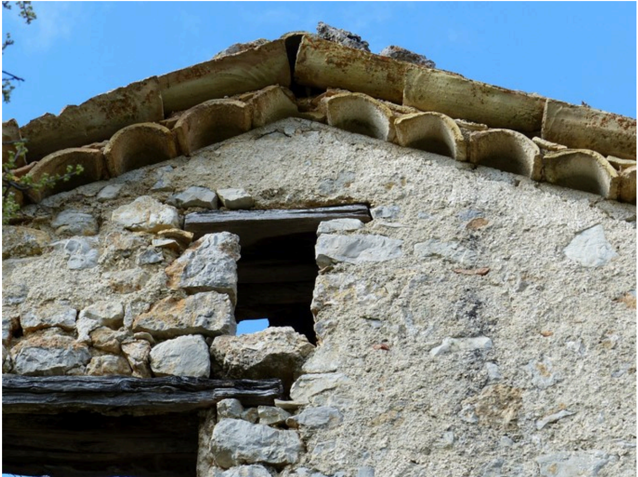
Pignon sud, saillie de rive constituée d'un rang de génoise, peint en blanc.
