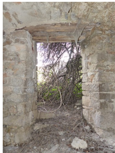
Étage de soubassement, mur sud. Porte. Phot. Alexeï Laurent IVR84_20162600818NUCA
