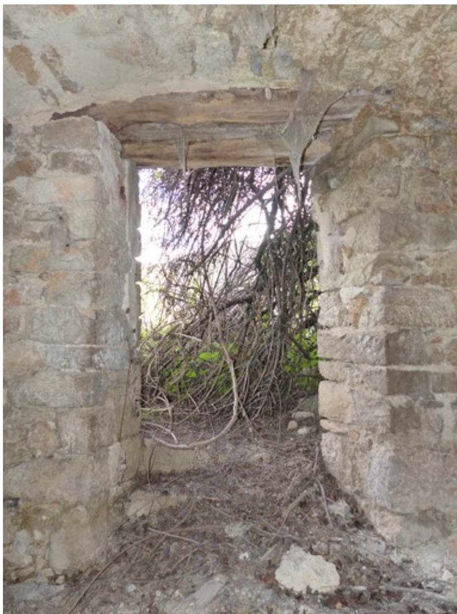
Etage de soubassement, mur sud. Porte.
