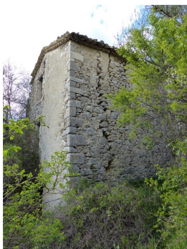
Vue d'ensemble prise du sud-est. Phot. Alexeï Laurent IVR84_20162600810NUCA
