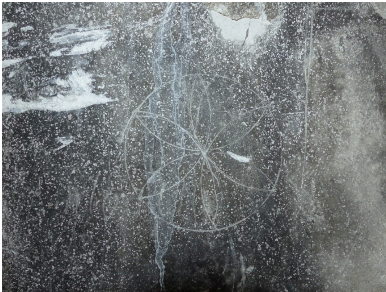
Rez-de-chaussée surélevé, logis. Cloison sous l'escalier, rosace gravée.
