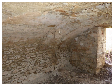
Étage de soubassement, étable. Vue de volume prise du nord-ouest.
