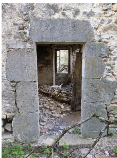
Elévation nord, premier niveau. Porte du logis. Phot. Alexeï Laurent IVR84_20162600814NUCA
