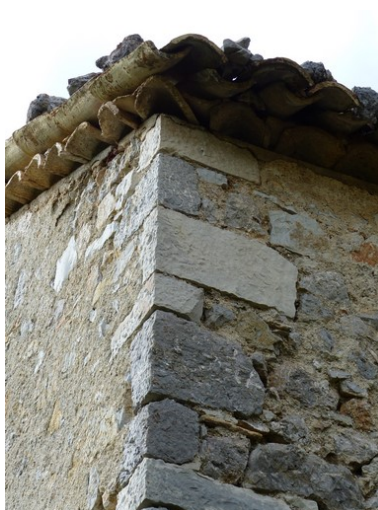
Chaîne d'angle sud-est. Phot. Alexeï Laurent IVR84_20162600811NUCA
