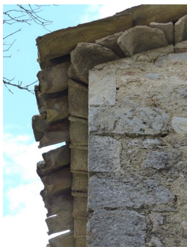
Chaîne d'angle sud-ouest, passage du rang de génoise de l'avant-toit vers la saillie de rive. Phot. Alexeï Laurent
