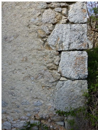
Chaîne d'angle sud-est. Phot. Alexeï Laurent IVR84_20162600807NUCA
