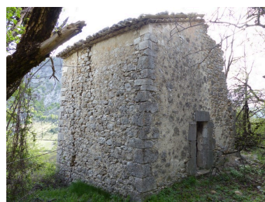
Vue d'ensemble prise du nord-est. Phot. Alexeï Laurent IVR84_20162600812NUCA
