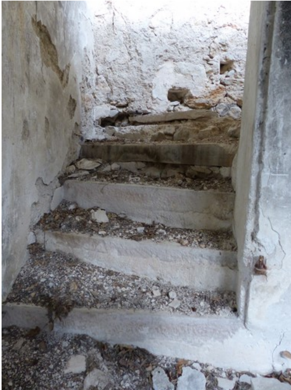
Rez-de-chaussée surélevé, logis. Angle nord-est, escalier. Trois marches d'appel en pierre de taille.
