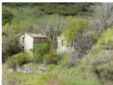
Vue de situation prise du sud-est.
