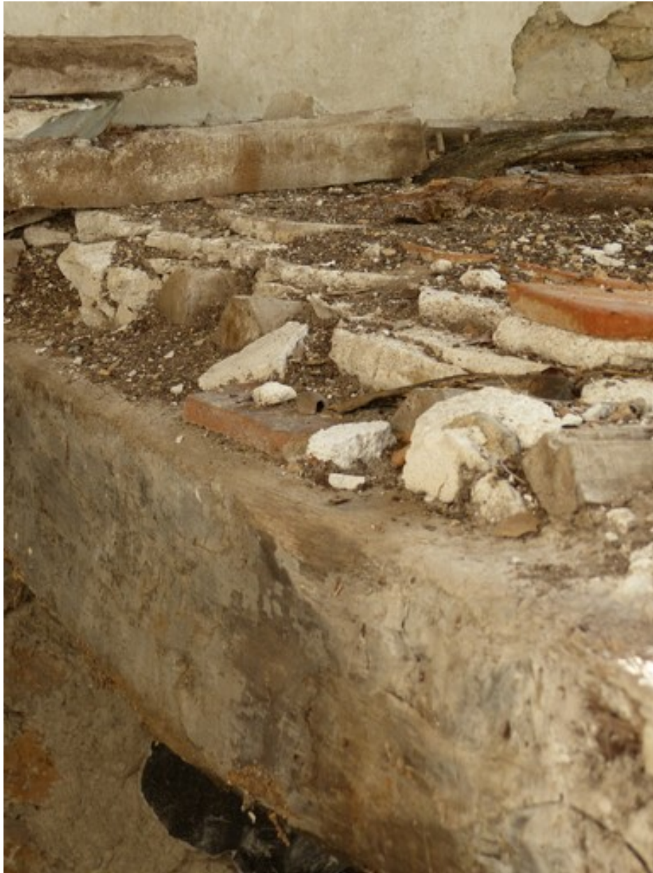
Etage, logis. Coupe du sol : solive, cartons, chape de mortier, carreaux de terre cuite.
