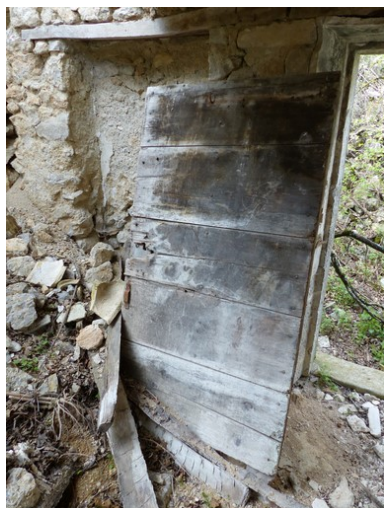
Rez-de-chaussée surélevé, logis. Mur nord, porte. Phot. Alexeï Laurent IVR84_20162600819NUCA
