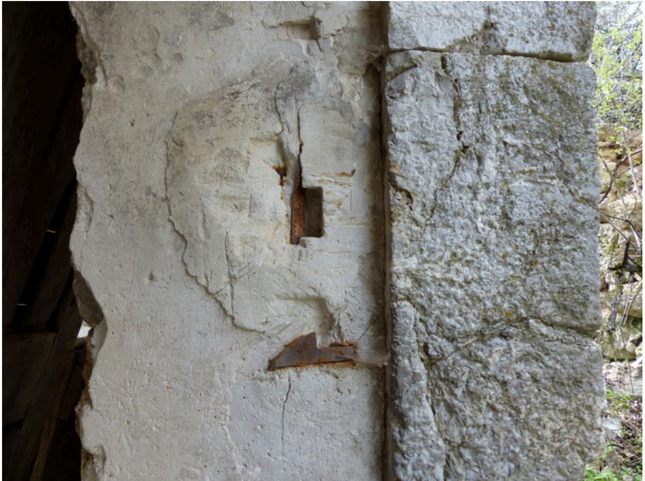
Rez-de-chaussée surélevé, logis. Mur nord, détail de l'embrasure de la porte.
