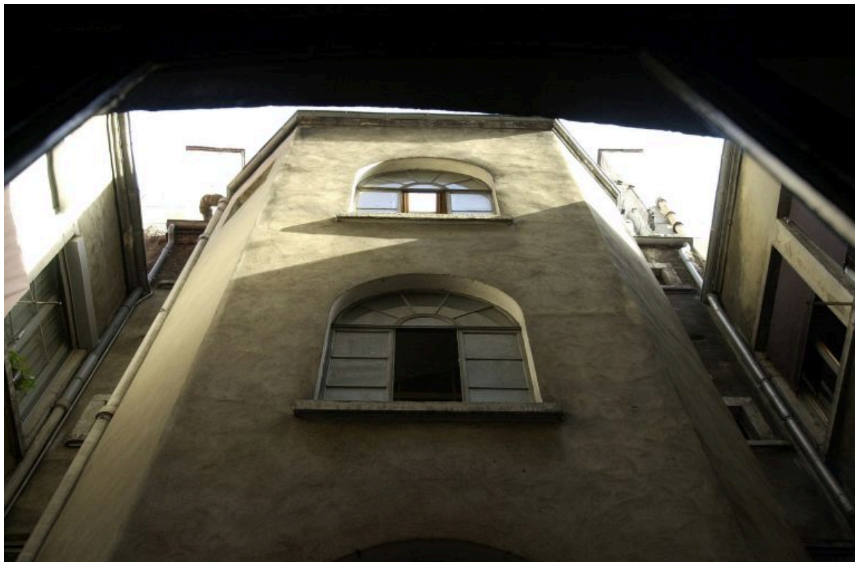
Elévation sur cour de la cage d'escalier
