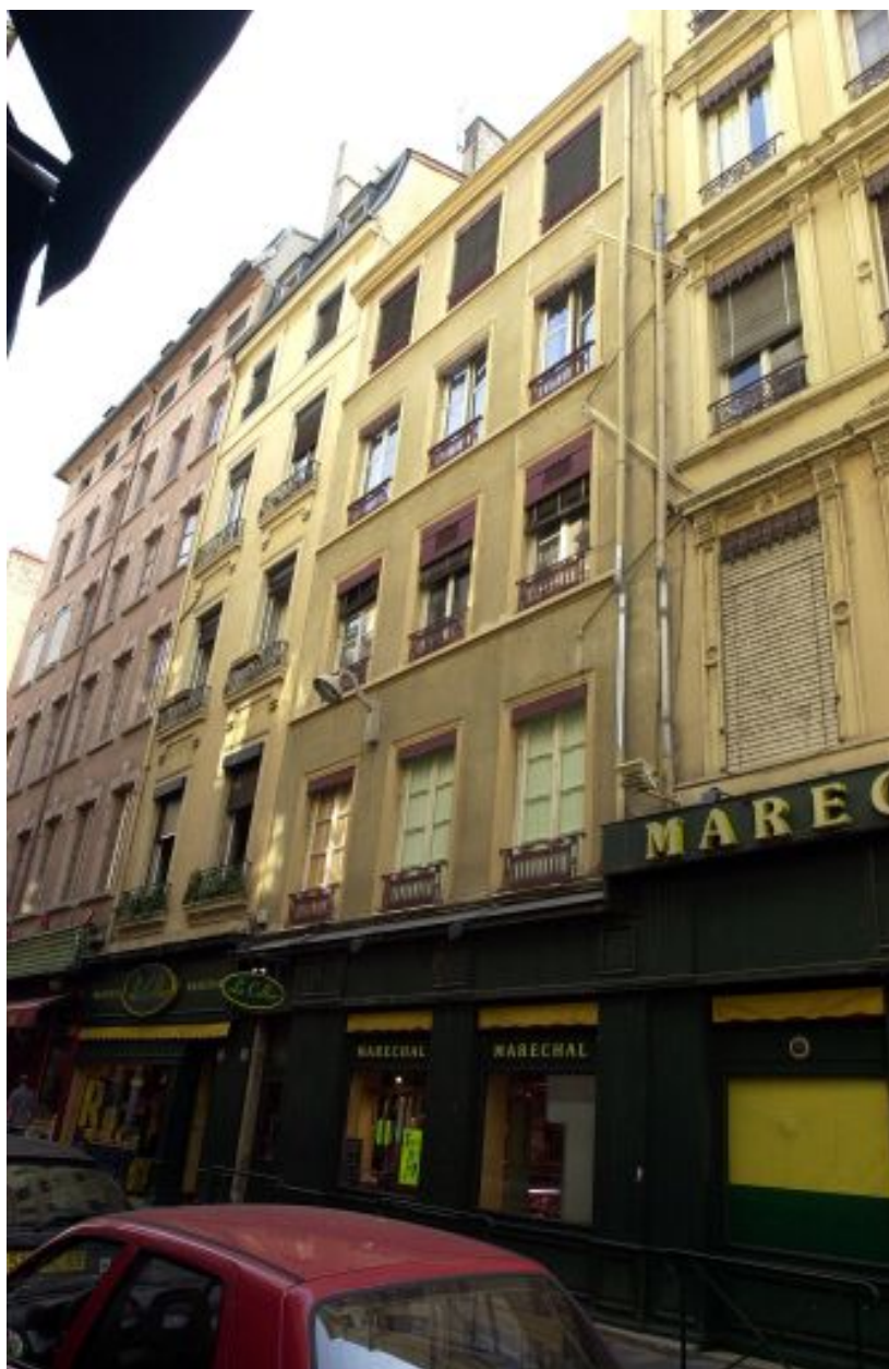
Façade principale sur la rue Lanterne
