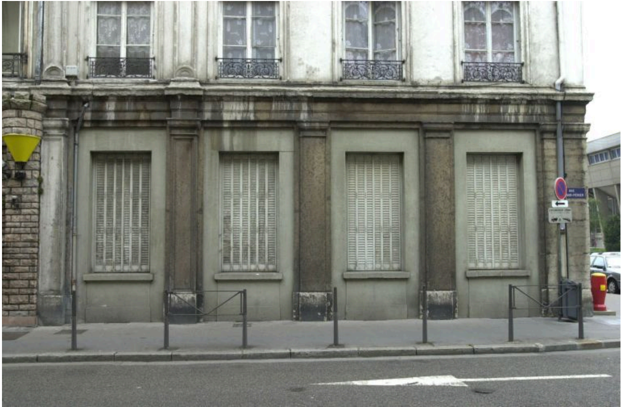
Rez-de-chaussée, rue Casimir-Perier
