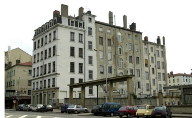
Vue de 3/4 droit Phot. François Blanchetière IVR82_20016902145NUCA
