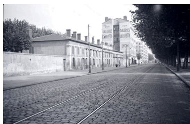
Vue d'ensemble depuis le sud-est, vers 1955 Repro. Jacques Gastineau IVR82_20036900330NUC
