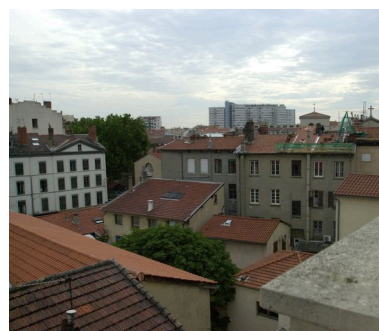
Vue de la toiture depuis le sud-ouest Phot. Maryannick Chalabi IVR82_20096901032NUCA
