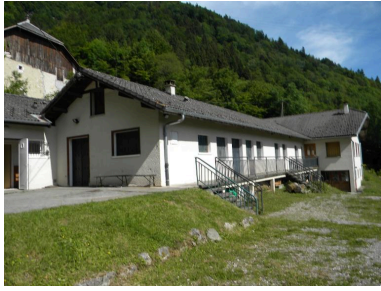
Vue d'ensemble de l'ancien bâtiment de logement des ouvriers.
