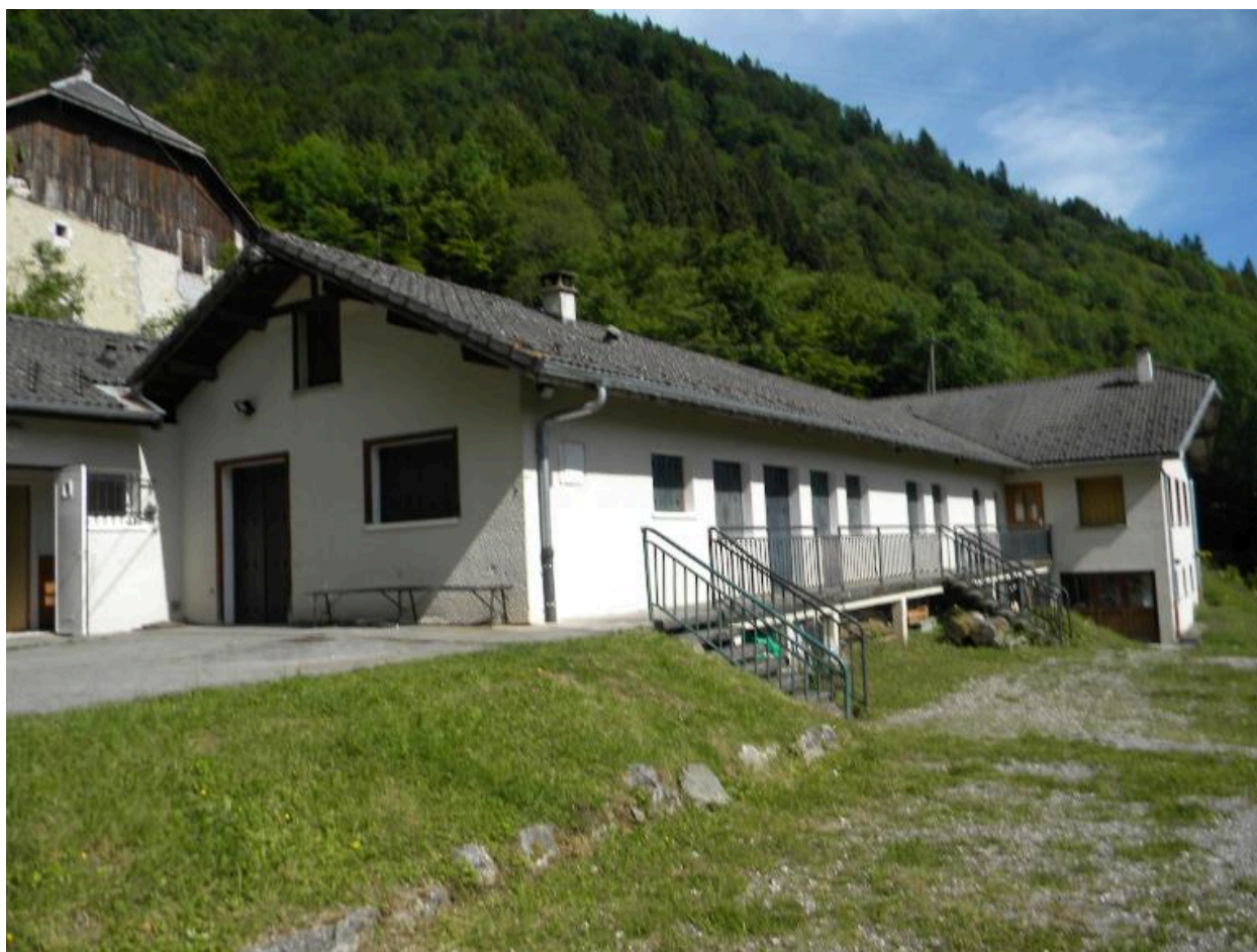
Vue d'ensemble de l'ancien bâtiment de logement des ouvriers.
