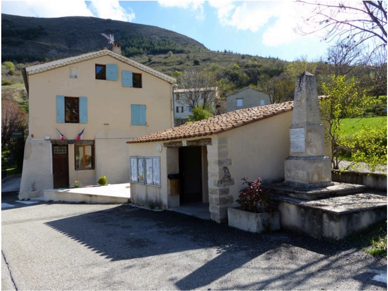
Vue de situation prise du sud-ouest.
