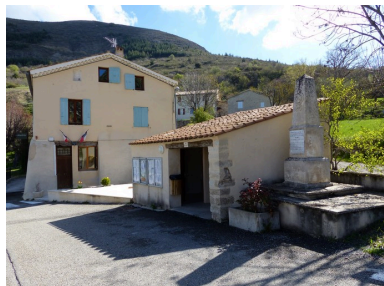
Vue de situation prise du sud-ouest. Phot. Alexeï Laurent IVR84_20162600171NUCA
