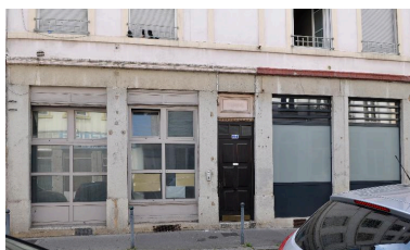
Vue rapprochée du rez-de-chaussée Phot. Magali Delavenne IVR84_20176901013NUCA
