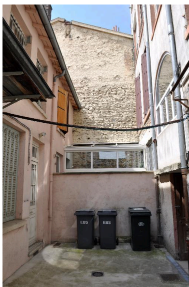
Vue de la cour Phot. Magali Delavenne IVR84_20176901017NUCA
