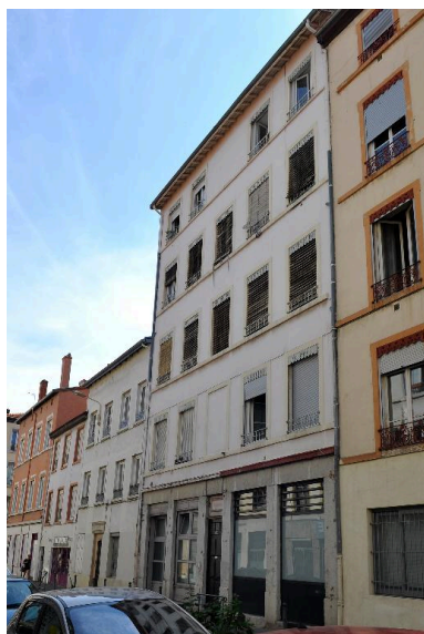
Vue générale, élévation sur rue Phot. Magali Delavenne IVR84_20176901012NUCA
