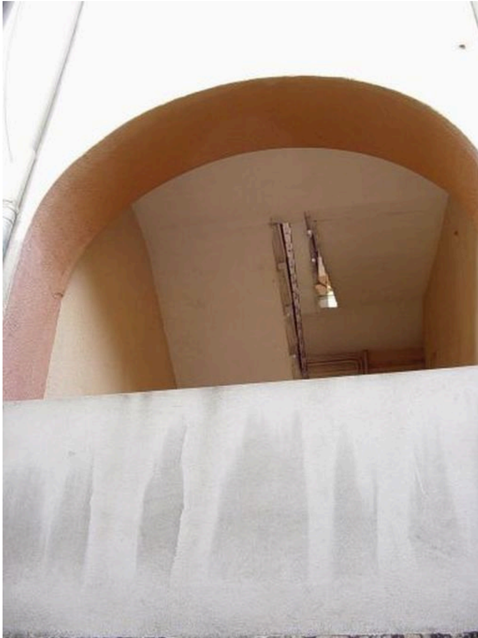
Vue extérieure d'une des baies éclairant les paliers de l'escalier
