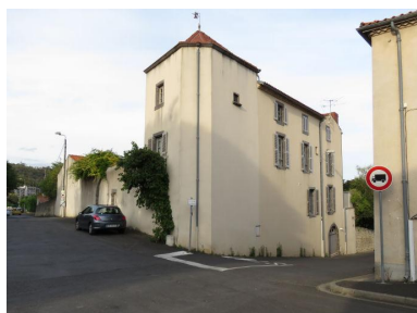
Vue d'ensemble depuis la rue Phot. Bruno Decrock IVR84_20216300113NUCA
