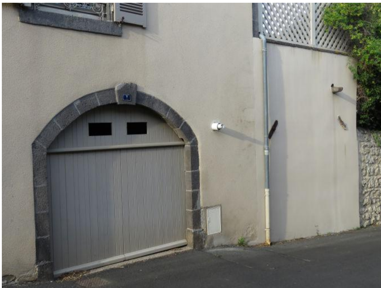
Vue de détail : entrée du cuvage sur allée des Cerisiers
