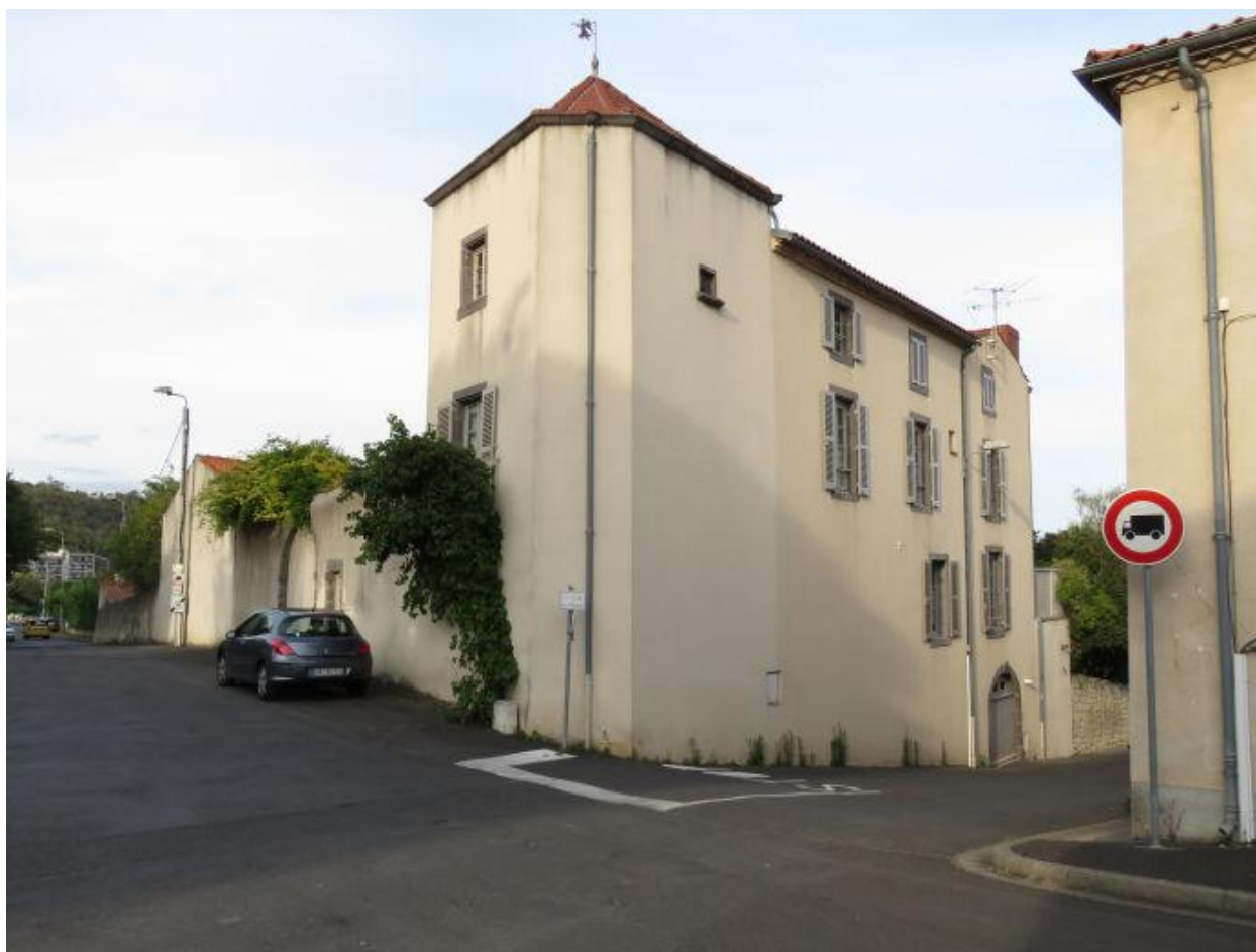
Vue d'ensemble depuis la rue
