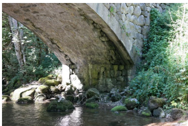
Pont de Pâques, vue de la pile rive gauche Phot. Pascale Renard IVR84_20207401529NUCA
