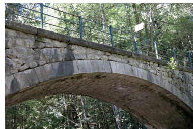
Pont de Pâques, vue de l'intrados Phot. Pascale Renard IVR84_20207401530NUCA
