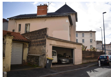
Garage sur la rue Michalias Phot. Félicie Fougère IVR84_20246300939NUCA
