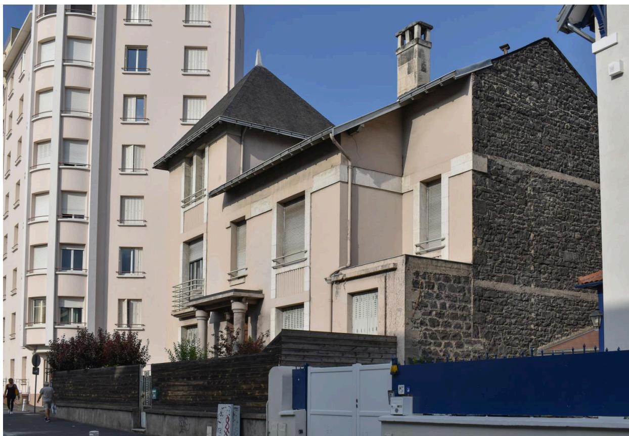
Façade et élévation latérale aveugle
