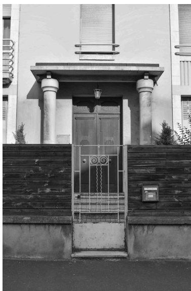
Porte d'entrée bâtarde et auvent Phot. Félicie Fougère IVR84_20246300942NUC
