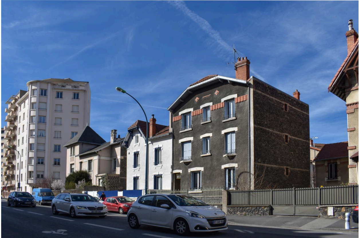
Elévations sur le boulevard Fleury (du 16 au 22)
