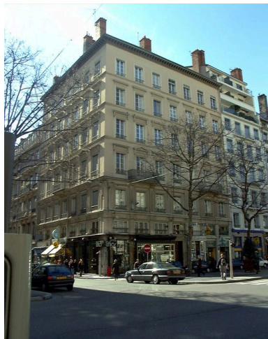
Vue générale des façades sur rue Phot. Bernard Ducouret IVR82_20016900830NUCA
