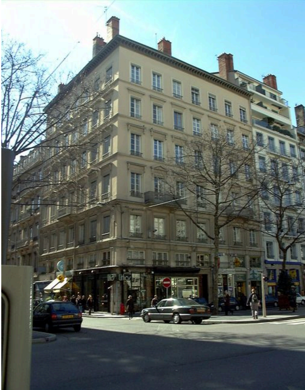
Vue générale des façades sur rue
