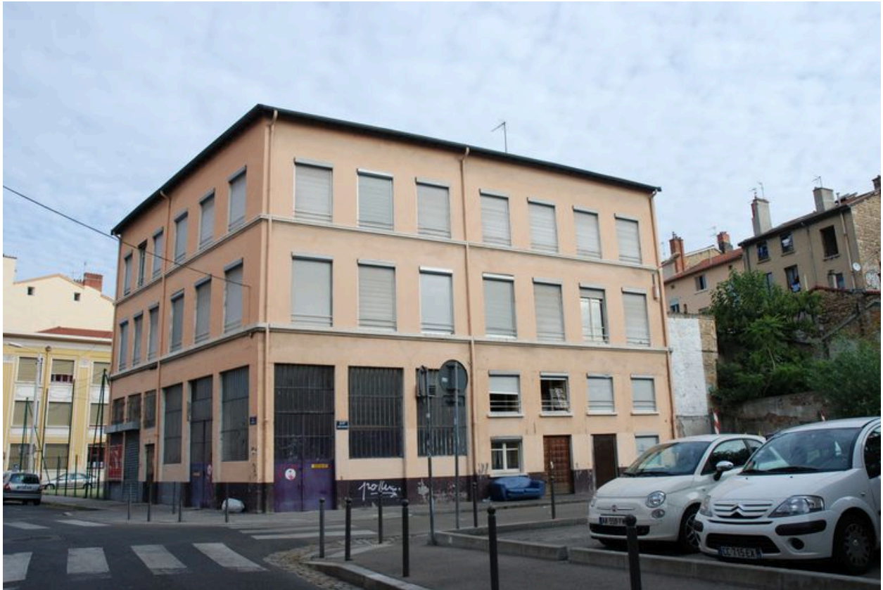
Vue générale (état août 2012).
