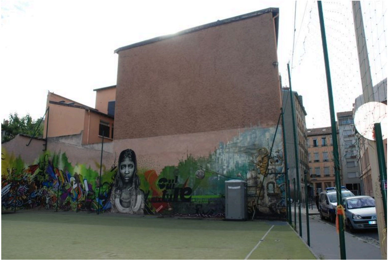
Vue du pignon ouest (état août 2012).
