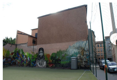
Vue du pignon ouest (état août 2012). Phot. Catherine Guillot IVR82_20126901096NUCA
