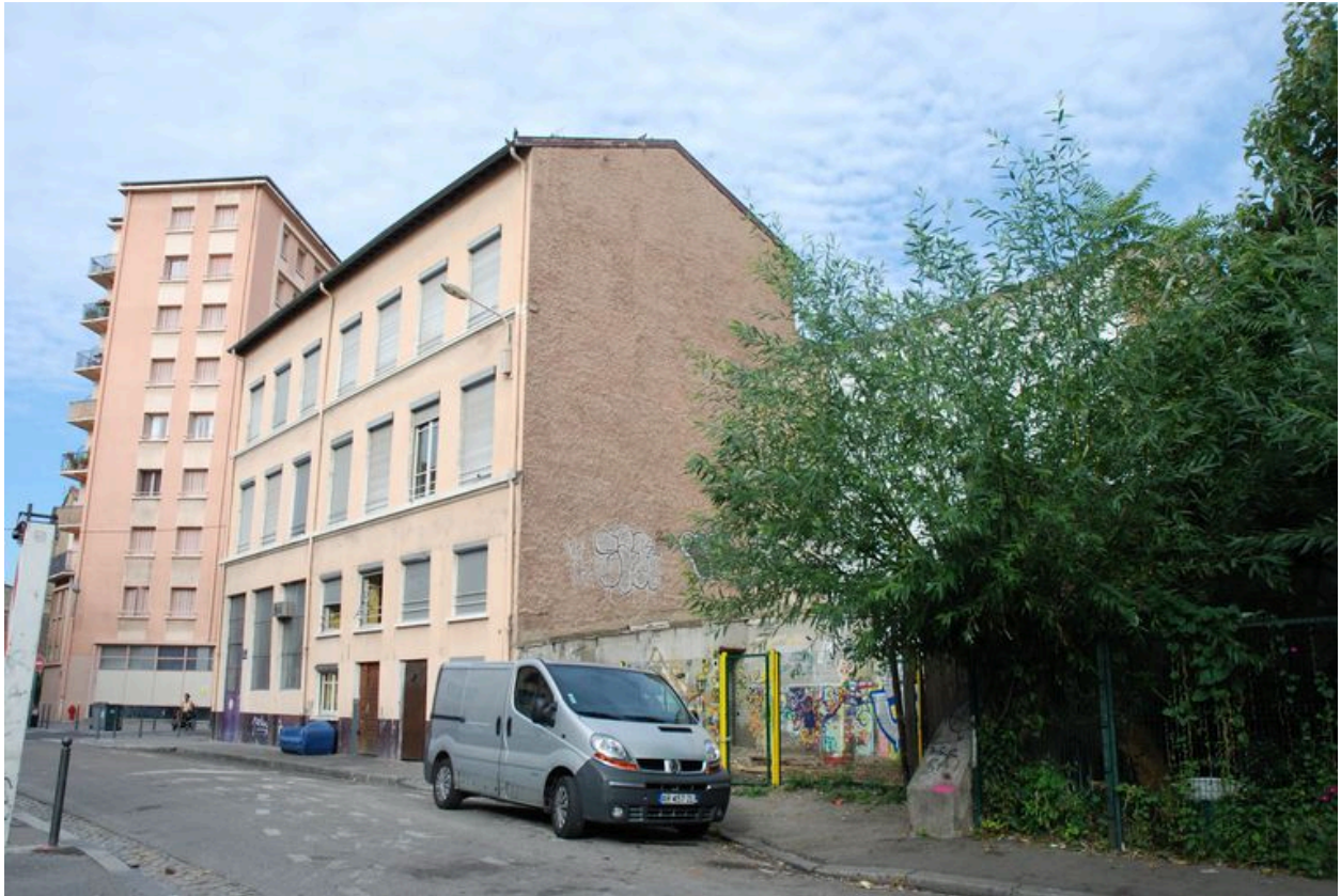
Vue de situation depuis la rue Mazagran (état août 2012).
