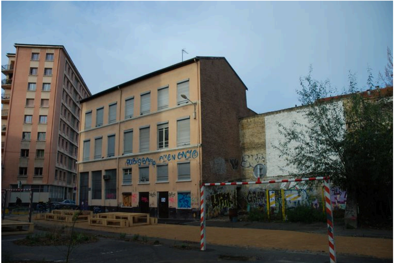
Vue générale (état novembre 2012).
