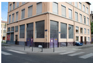
Détail des ateliers situés au rez-de-chaussée (état août 2012). Phot. Catherine Guillot IVR82_20126901095NUCA
