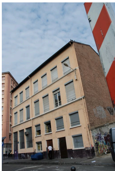
Vue de l'élévation sur la rue Mazagran (état août 2012). Phot. Catherine Guillot IVR82_20126901094NUCA
