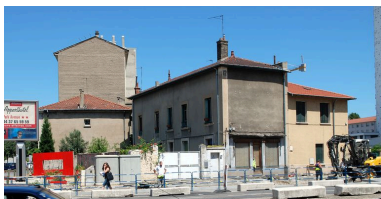
Elévations sud et ouest Phot. Véronique Belle IVR82_20096903472NUCA
