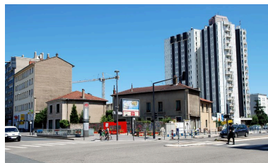
Elévations sud et ouest Phot. Véronique Belle IVR82_20096903473NUCA
